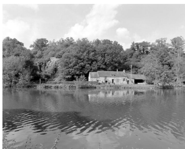
Vue d'ensemble depuis la rive gauche du bâtiment qu'occupaient le logement du meunier et les dépendances du moulin (transformées en pièces d'habitation). Phot. François Lasa IVR52_20015300455X
