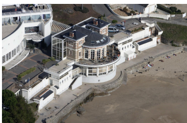
Casino-centre de thalassothérapie de Gourmalon, Pornic. Phot. Denis Pillet IVR52_20114401171NUCA
