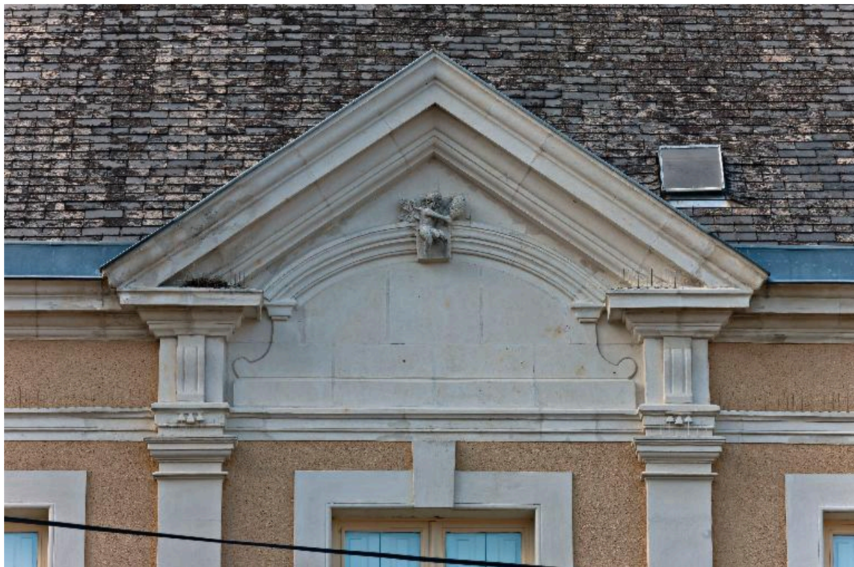
Détail du fronton de l'étage du n° 18, remanié en 1893-1894.
