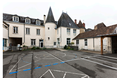
Elevations postérieures de l'ancienne maison. Phot. Yves Guillotin IVR52_20177200759NUCA
