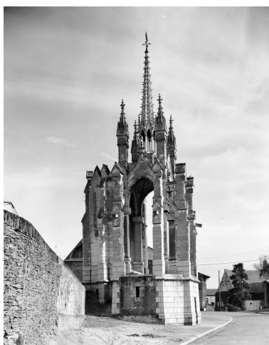
Elévation latérale gauche. Phot. François Lasa IVR52_19854900540V
