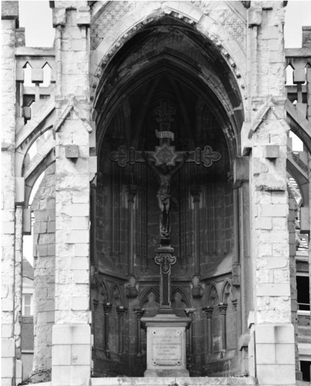
Intérieur, vue d'ensemble.
