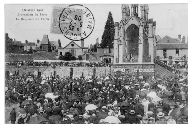
La place et le reposoir, depuis l'est, lors d'une procession du Grand sacre, en 1906, carte postale, d'après une fotogr. de R. Rivière, début 20e siècle.
