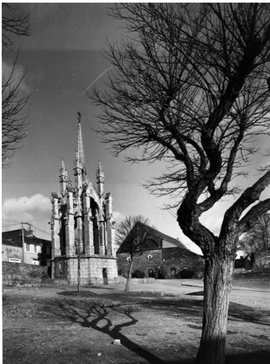
Vue de situation, au sud.
