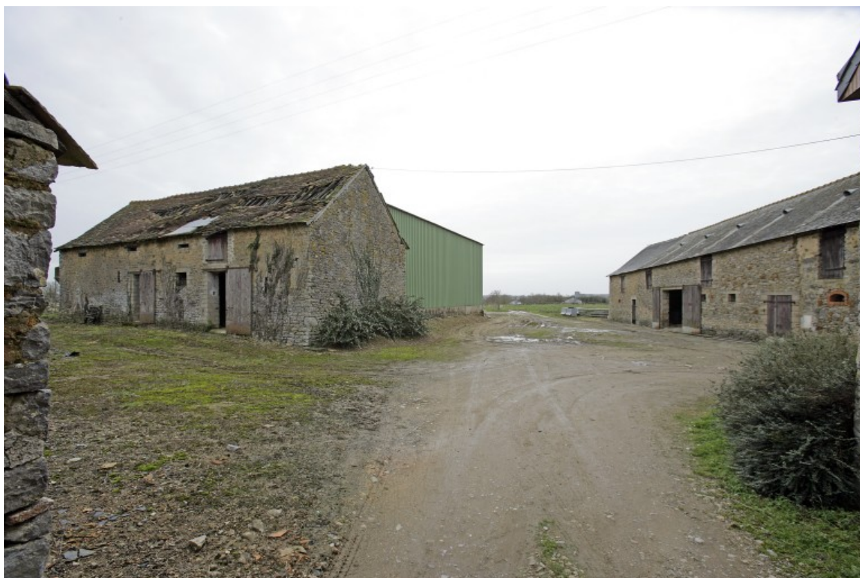
La seconde étable et l'étable-grange vues depuis l'entrée de la cour au nord.
