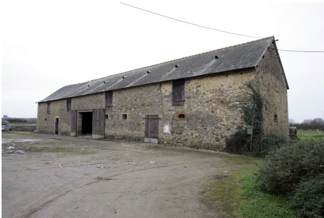
L'étable-grange vue depuis la cour au nord-est.
