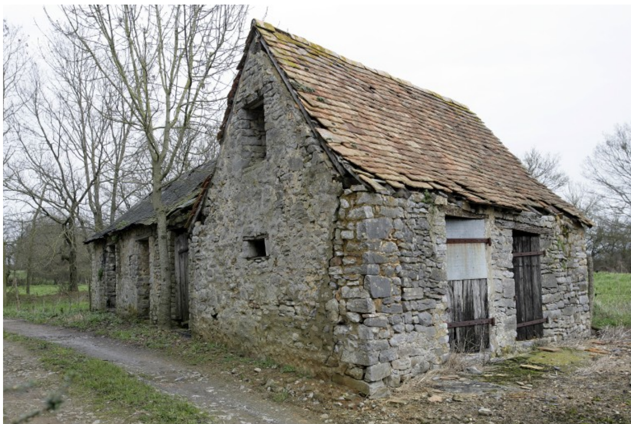
La porcherie vue depuis le sud-ouest.
