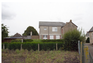
L'ancienne mairie- école vue depuis le nord. Phot. François Lasa IVR52_20055302090NUCA
