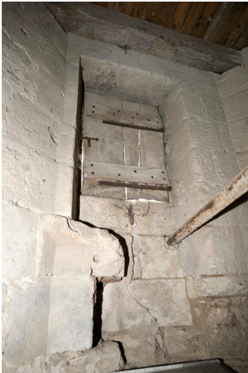
Tourelle d'escalier. Niveau intermédiaire entre l'étage et le comble. Fenêtre à coussiège. L'huissierie semble conserver des éléments d'origine (seconde moitié XVe siècle).
