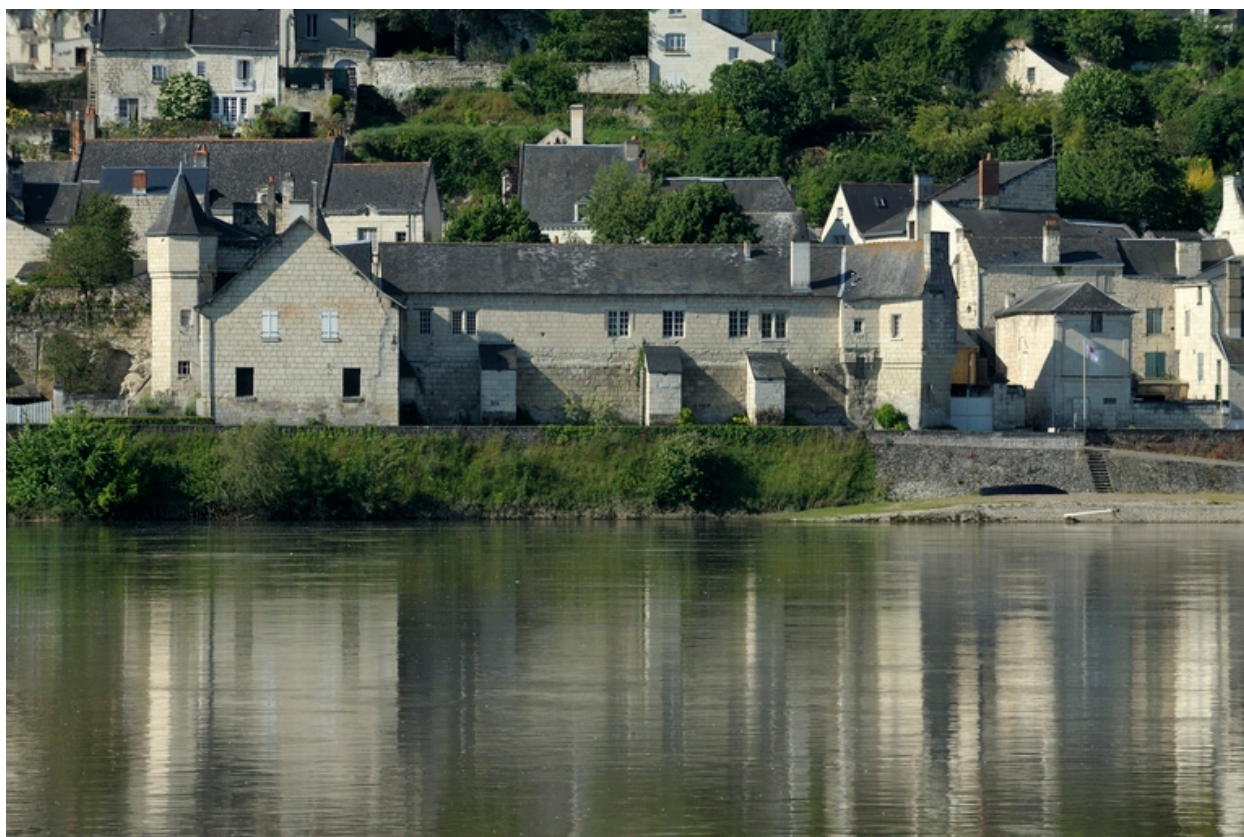
Ensemble formant à l'origine des logements, greniers et écuries dépendants du château, aujourd'hui maison (à gauche) et école (à droite).
