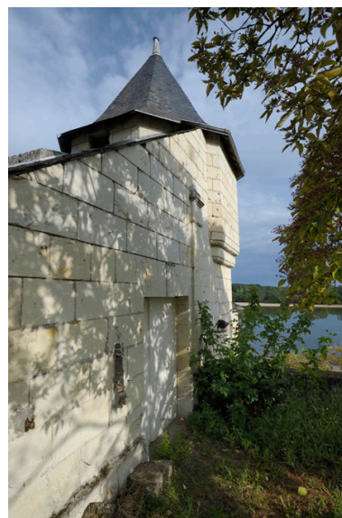
Flanquement en appentis (XIXe siècle) contre l'ancien pignon sud et la tourelle du corps est. Un pilastre, seul, anime le pignon de cet appentis. Phot. Bruno Rousseau IVR52_20124901637NUCA
