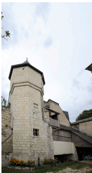
Tourelle d'escalier, avec traces d'arrachement de la partie sud du gouttereau ouest de la maison du Sénéchal. Phot. Bruno Rousseau IVR52_20124901641NUCA
