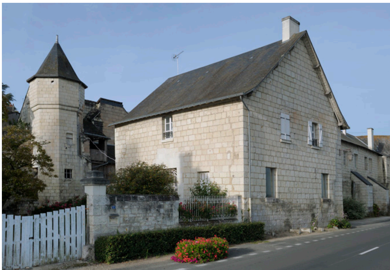
Vue générale du corps est.
