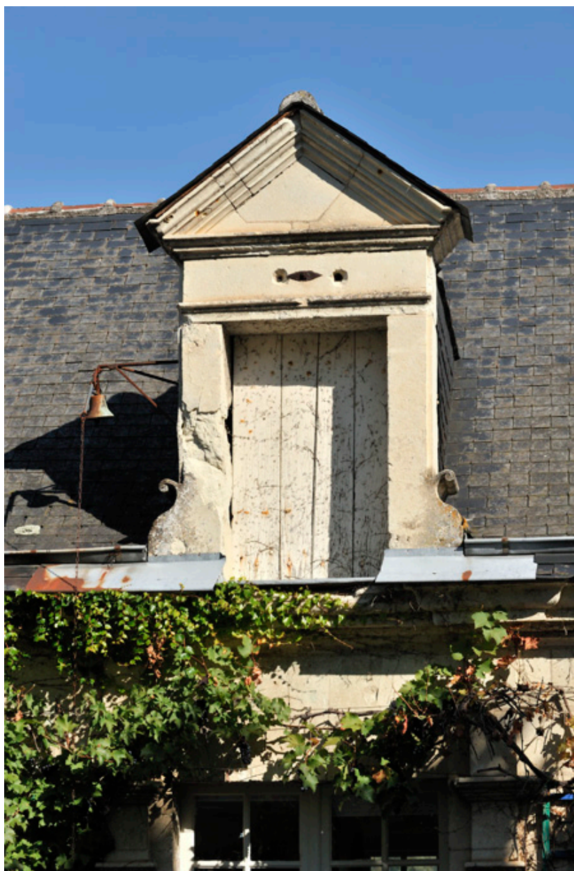
Corps ouest, lucarne axiale du bâtiment principal.
