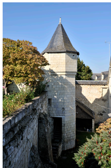
Tourelle d'escalier qui assurait la distribution de l'ancien logis et la communication entre les bords du fleuve et la basse-cour du château. Phot. Bruno Rousseau, Phot. Youenn Communeau IVR52_20114902730NUCA
