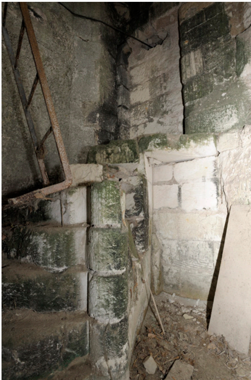
Tourelle d'escalier. Palier bas et vestiges de l'ancien escalier, avec marches à gorge au collet.
