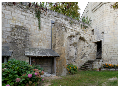
Mur de soutènement de l'ancienne basse-cour du château, en terrasse, avec confortements. Phot. Bruno Rousseau IVR52_20124901639NUCA
