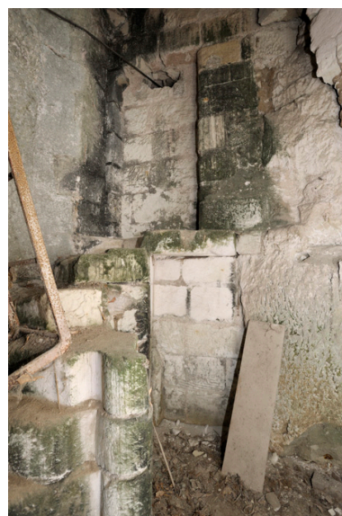
Tourelle d'escalier. Porte (obturée) qui donnait accès à la salle sud du rez-de-chaussée surélevé. Phot. Bruno Rousseau IVR52_20124901645NUCA
