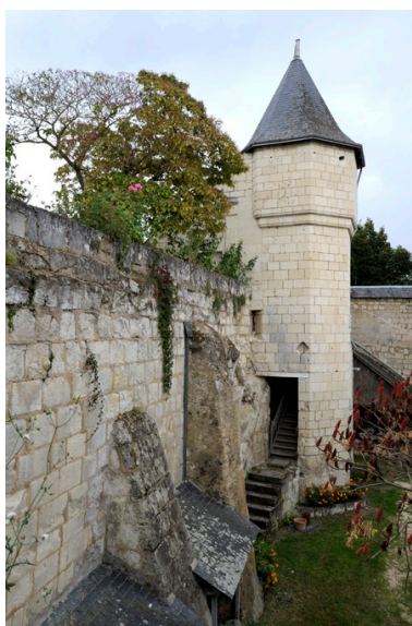
Tourelle d'escalier édifée contre un affleurement rocheux et le mur de soutènement de la terrasse de la basse-cour. Phot. Bruno Rousseau IVR52_20124901640NUCA
