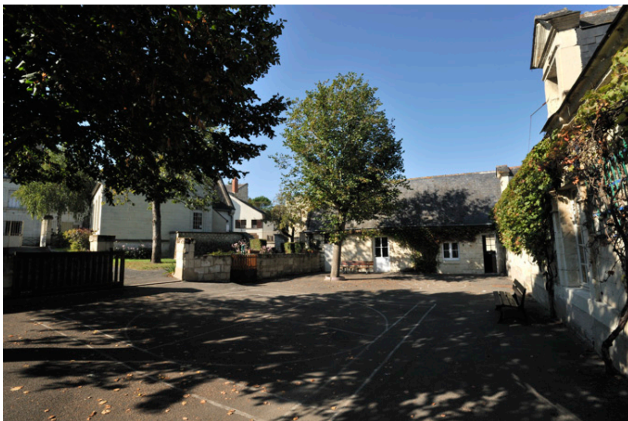
Cour et bâtiments : vue d'ensemble.
