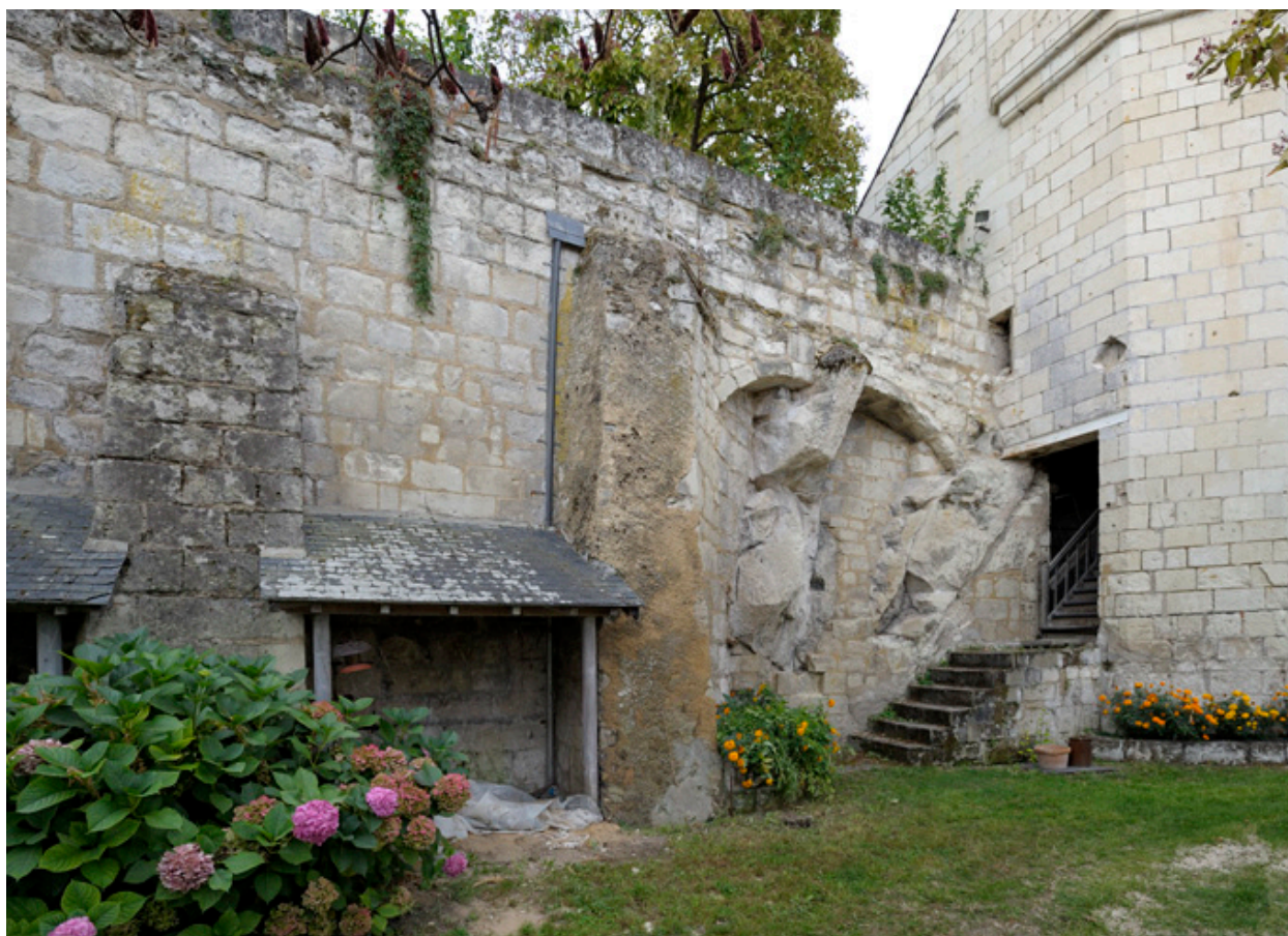
Mur de soutènement de l'ancienne basse-cour du château, en terrasse, avec confortements.
