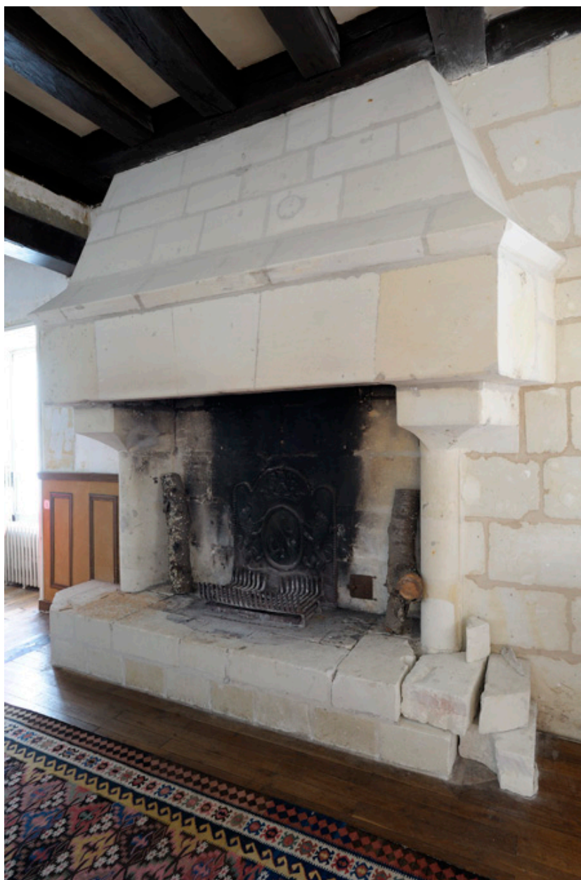
Corps est, rez-de-Chaussée surélevé. Salle nord, pignon nord, cheminée (seconde moitié du XVe siècle).
