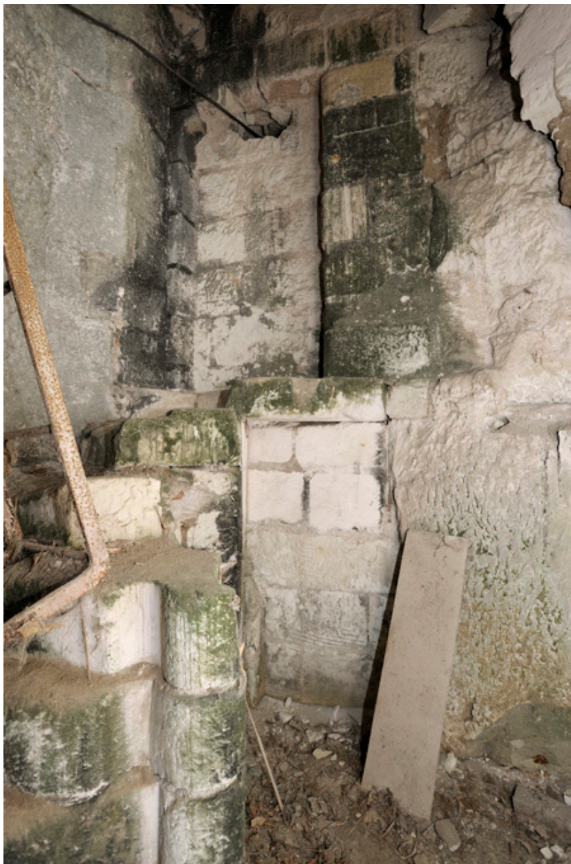
Tourelle d'escalier. Porte (obturée) qui donnait accès à la salle sud du rez-de-chaussée surélevé.
