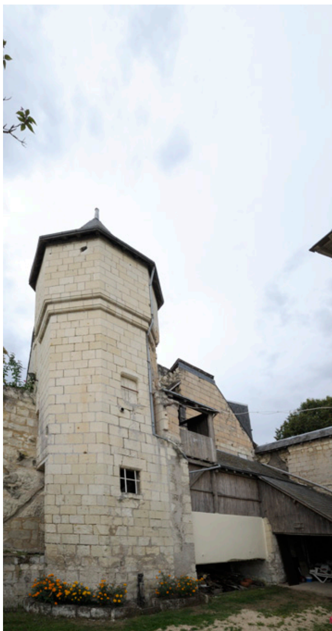
Tourelle d'escalier, avec traces d'arrachement de la partie sud du gouttereau ouest de la maison du Sénéchal.
