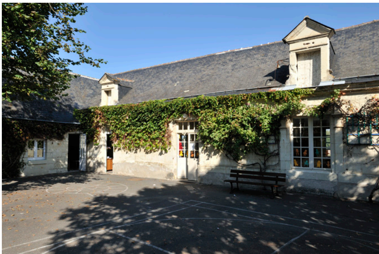
Corps ouest, bâtiment principal, depuis la cour.
