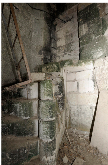
Tourelle d'escalier. Palier bas et vestiges de l'ancien escalier, avec marches à gorge au collet. Phot. Bruno Rousseau IVR52_20124901644NUCA
