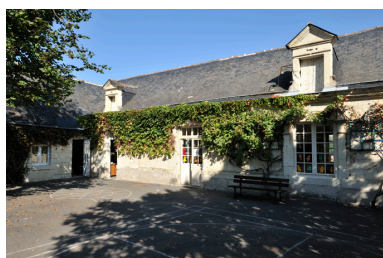
Corps ouest, bâtiment principal, depuis la cour. Phot. Bruno Rousseau, Phot. Youenn Communeau IVR52_20114902737NUCA
