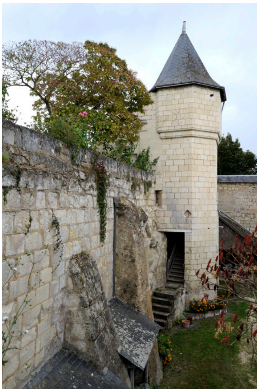
Tourelle d'escalier édifée contre un affleurement rocheux et le mur de soutènement de la terrasse de la basse-cour.
