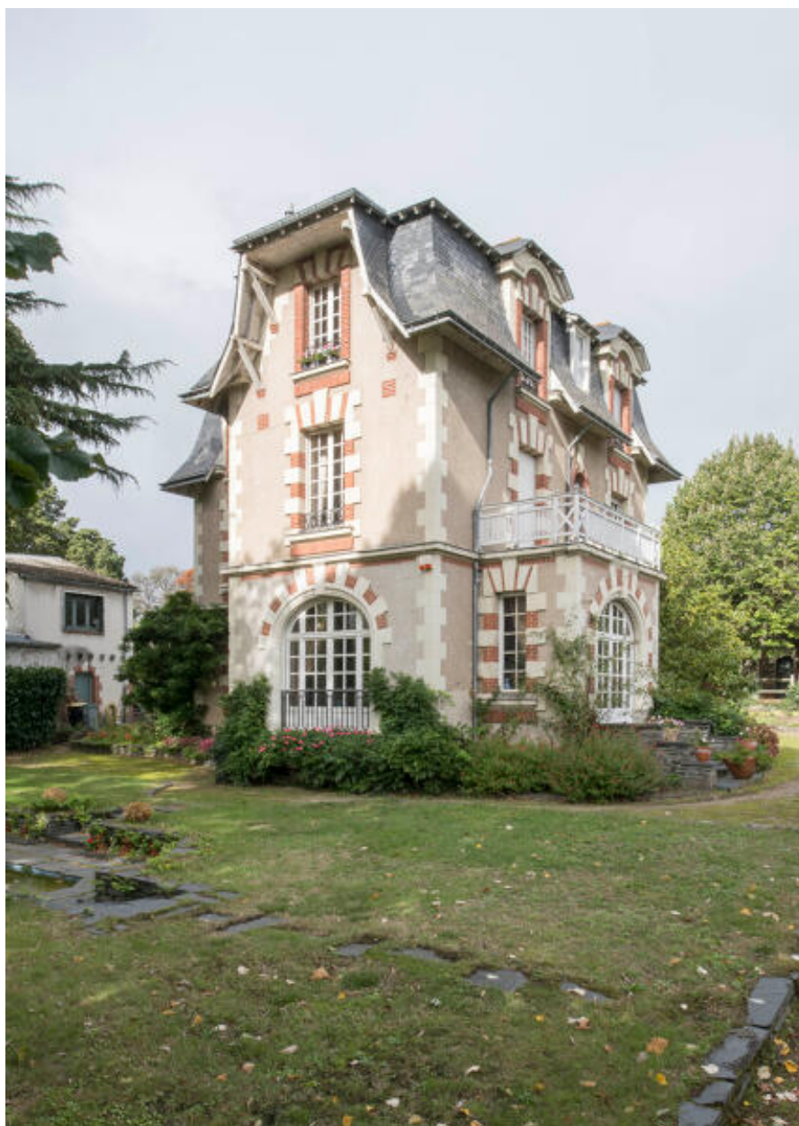
Vue de l'angle sud-est de la maison.
