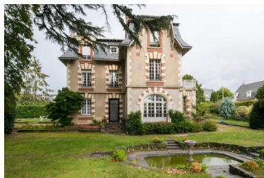
Vue de la façade sud et du jardin. Phot. Armelle Maugin IVR52_20204900463NUCA
