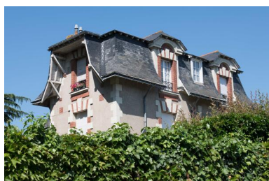
Détails de la toiture à pans brisés, à croupes et demi-croupes. Phot. Armelle Maugin IVR52_20204900188NUCA
