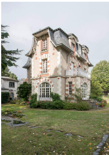
Vue de l'angle sud-est de la maison. Phot. Armelle Maugin IVR52_20204900461NUCA
