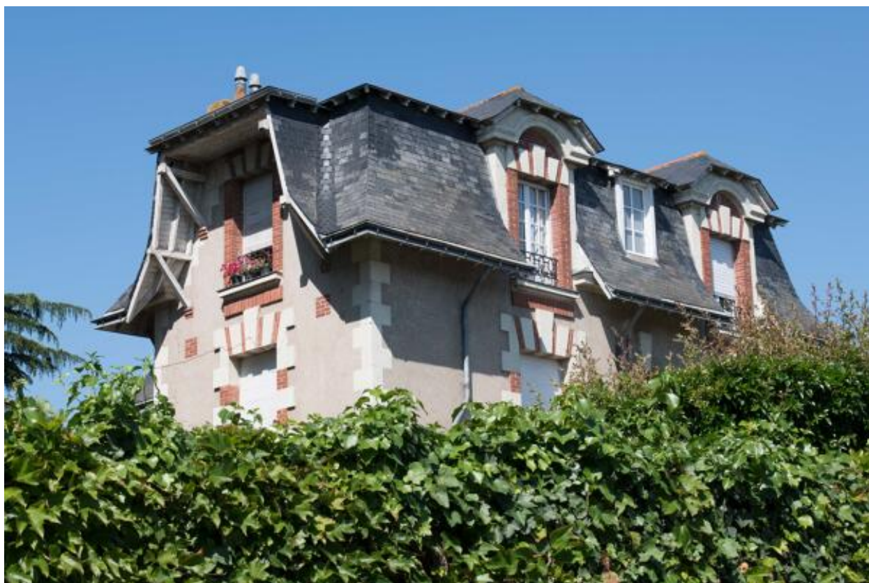
Détails de la toiture à pans brisés, à croupes et demi-croupes.
