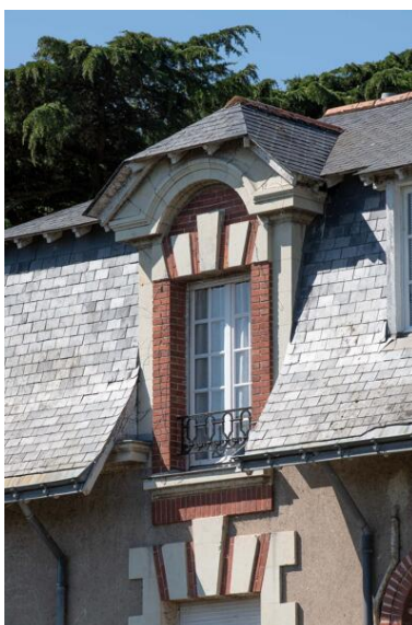
Détail d'une lucarne de la façade est. Phot. Armelle Maugin IVR52_20204900187NUCA
