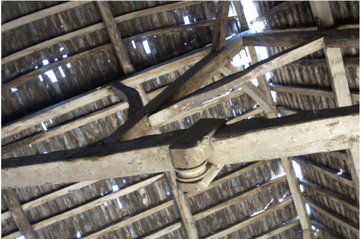
Détail de la charpente de la remise : poulie.
