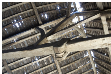
Détail de la charpente de la remise : poulie. Phot. François Lasa IVR52_20045302613NUCA
