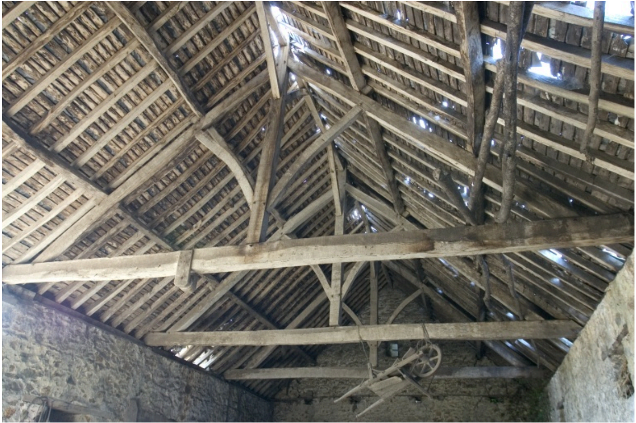
La charpente de la remise.
