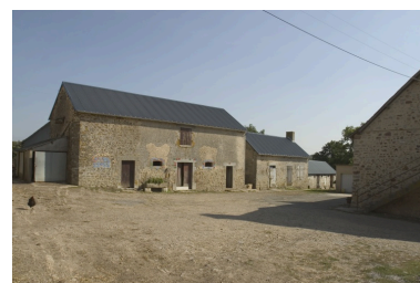
L'étable à chevaux, le fournil et la porcherie. Phot. François Lasa IVR52_20045302608NUCA
