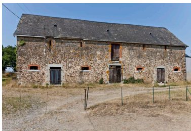
L'étable à vaches-grange. Phot. Yves Guillotin IVR52_20135300346NUCA
