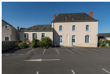
L'élévation postérieure. Phot. Thierry Seldubuisson IVR52_20225300790NUCA
