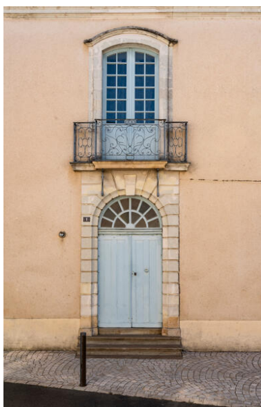
La travée centrale. Phot. Thierry Seldubuisson IVR52_20225300788NUCA
