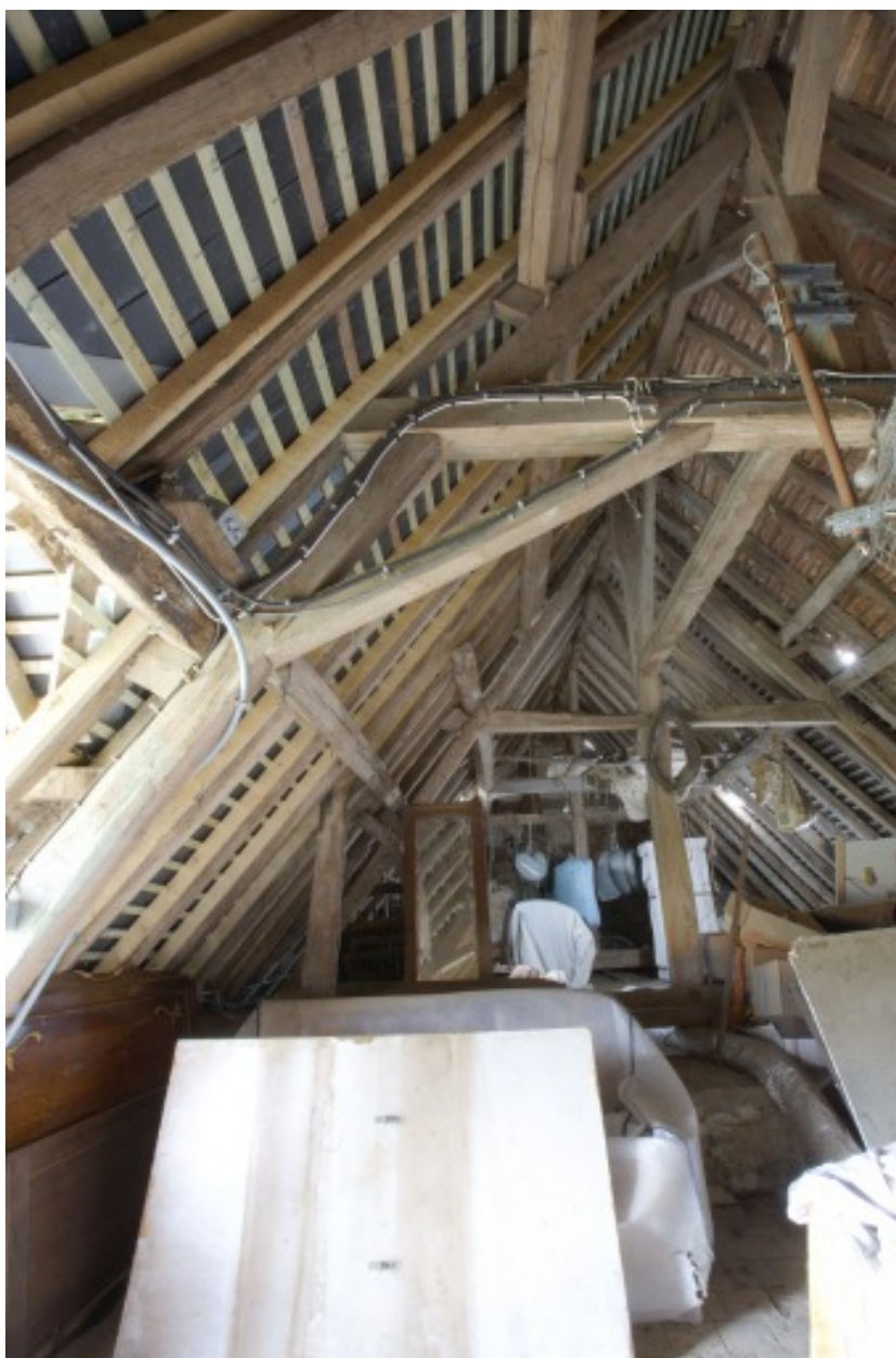
La charpente du logis vue depuis l'est.
