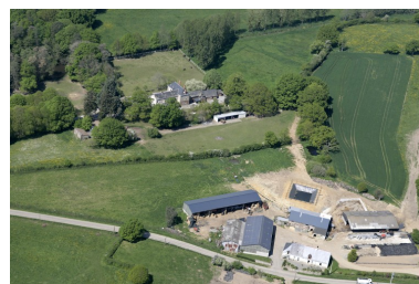
Vue aérienne depuis le sud- est. Au second plan, Chambord. Phot. François Lasa IVR52_20075301905NUCA
