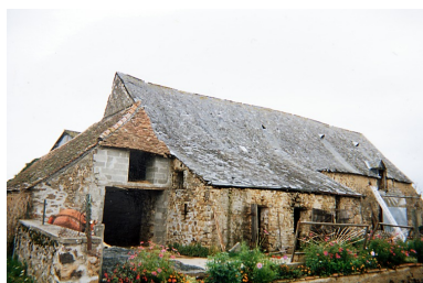
Photographie, années 1990 : la deuxième étable avant sa démolition. Phot. François Lasa IVR52_20055301981NUCA
