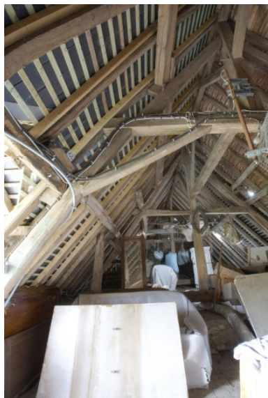
La charpente du logis vue depuis l'est.
