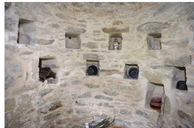
Détail des boulins de la tour nord-ouest. Phot. Denis Pillet IVR52_20084401884NUCA
