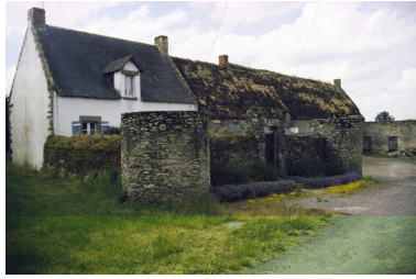
Vue d'ensemble depuis le nord-ouest. 1990. Phot. Denis (reproduction) Pillet IVR52_20094401006NUCA
