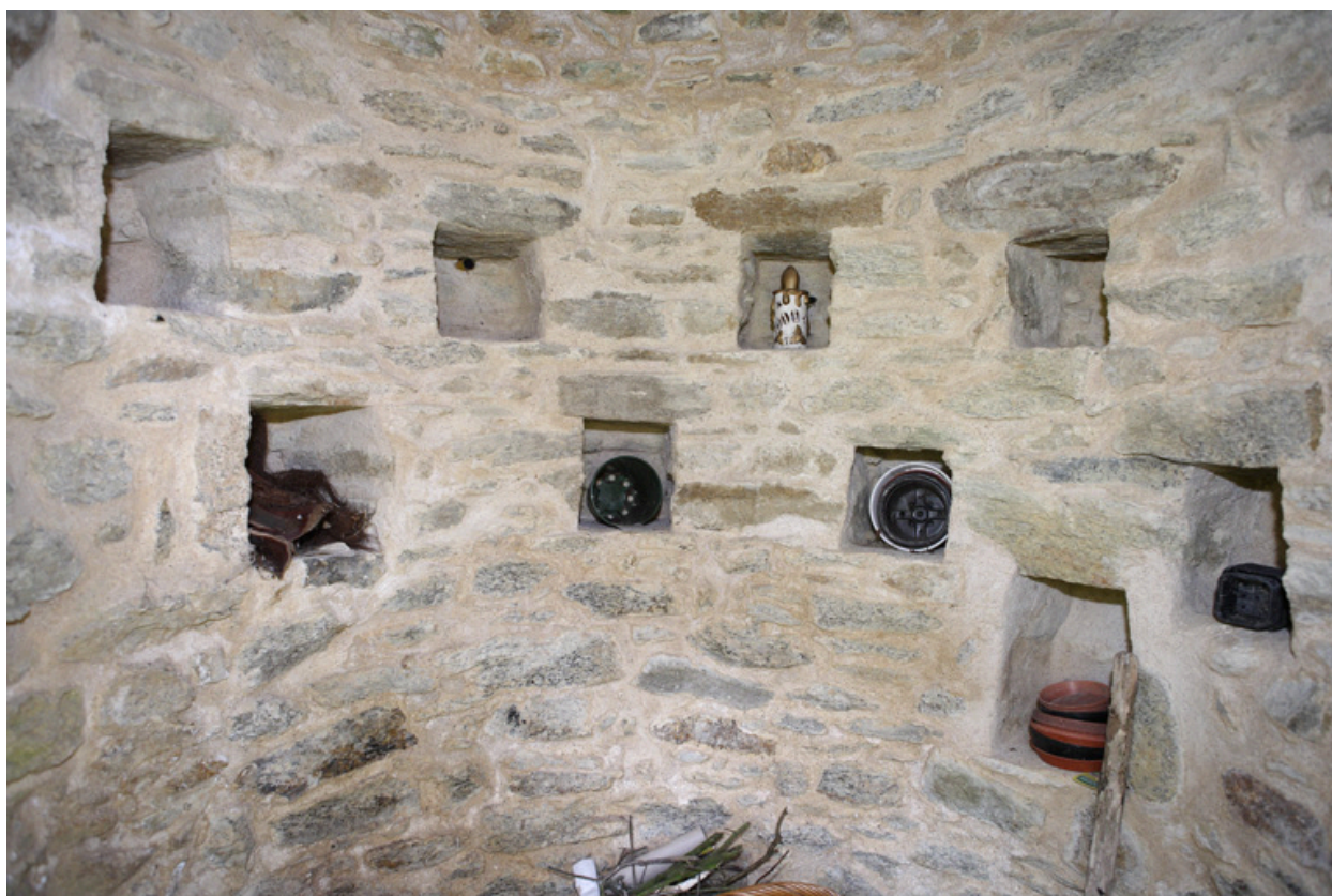
Détail des boulines de la tour nord-ouest.
