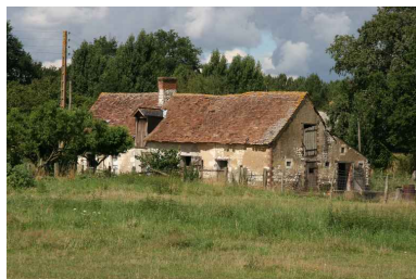
Les environs des Mortiers : maison et dépendances sous un même toit.
