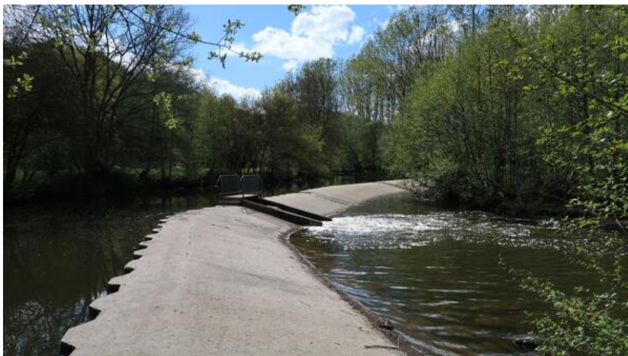
Grévisse. Détail de la chaussée de l'ancien moulin à eau.
