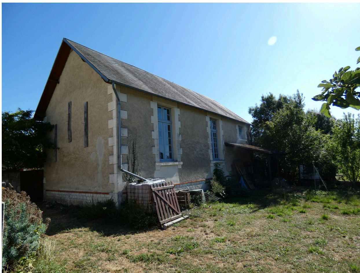
Le bâtiment de classe vu depuis le nord-est.
