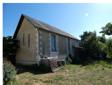
Le bâtiment de classe vu depuis le nord-est. Phot. Yannis Suire IVR52_20228501790NUCA
