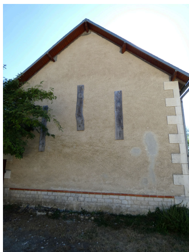
Le mur pignon est du bâtiment de classe, avec débordement de toit et solin. Phot. Yannis Suire IVR52_20228501789NUCA
