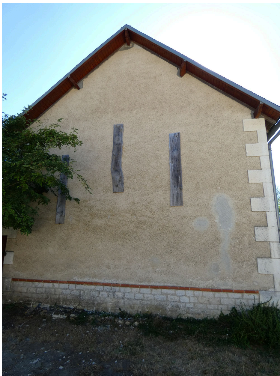
Le mur pignon est du bâtiment de classe, avec débordement de toit et solin.
