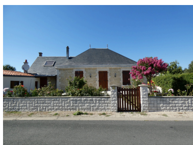
L'ancienne école, avec le jardin et l'ancien logement d'enseignant, vue depuis le sud. Phot. Yannis Suire IVR52_20228501787NUCA
