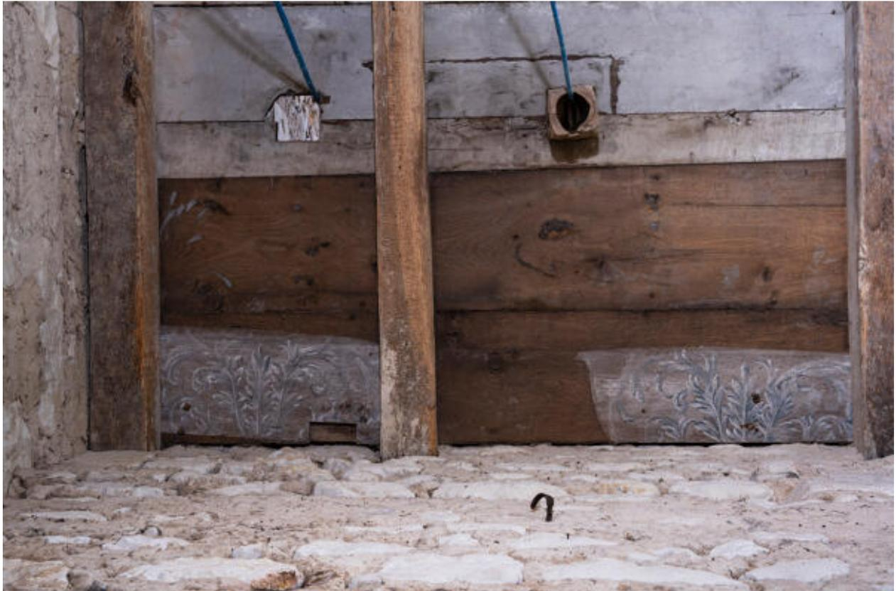
Éléments de lambris avec décor peint réemployés dans le plancher couvrant le rez-de-chaussée de la tour-clocher.
