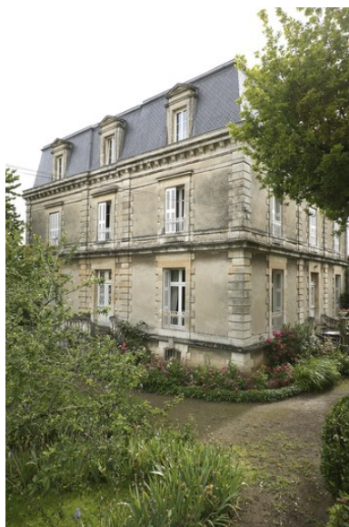
Vue de volume prise du sud-ouest. Phot. Patrice Giraud IVR52_20088500883NUCA
