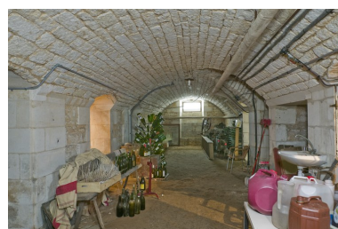
Vue du sous-sol. Phot. Patrice Giraud IVR52_20088500886NUCA
