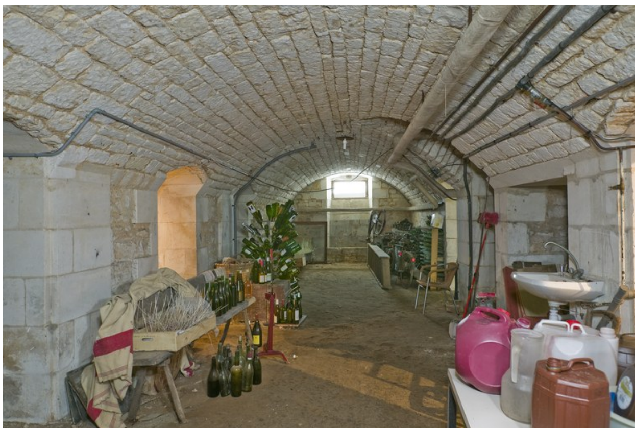
Vue du sous-sol.
