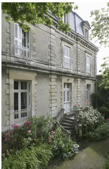
Façade sud, donnant sur la rue Millandy. Phot. Patrice Giraud IVR52_20088500884NUCA
