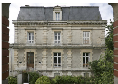
Vue de la façade arrière. Phot. Patrice Giraud IVR52_20088500878NUCA
