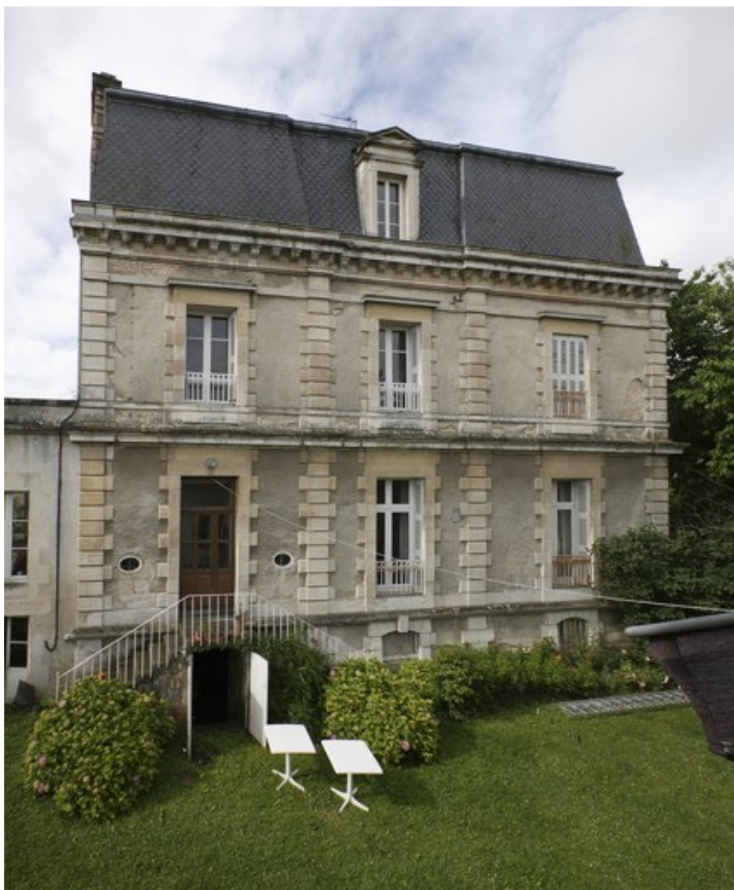
Vue de la façade arrière.
