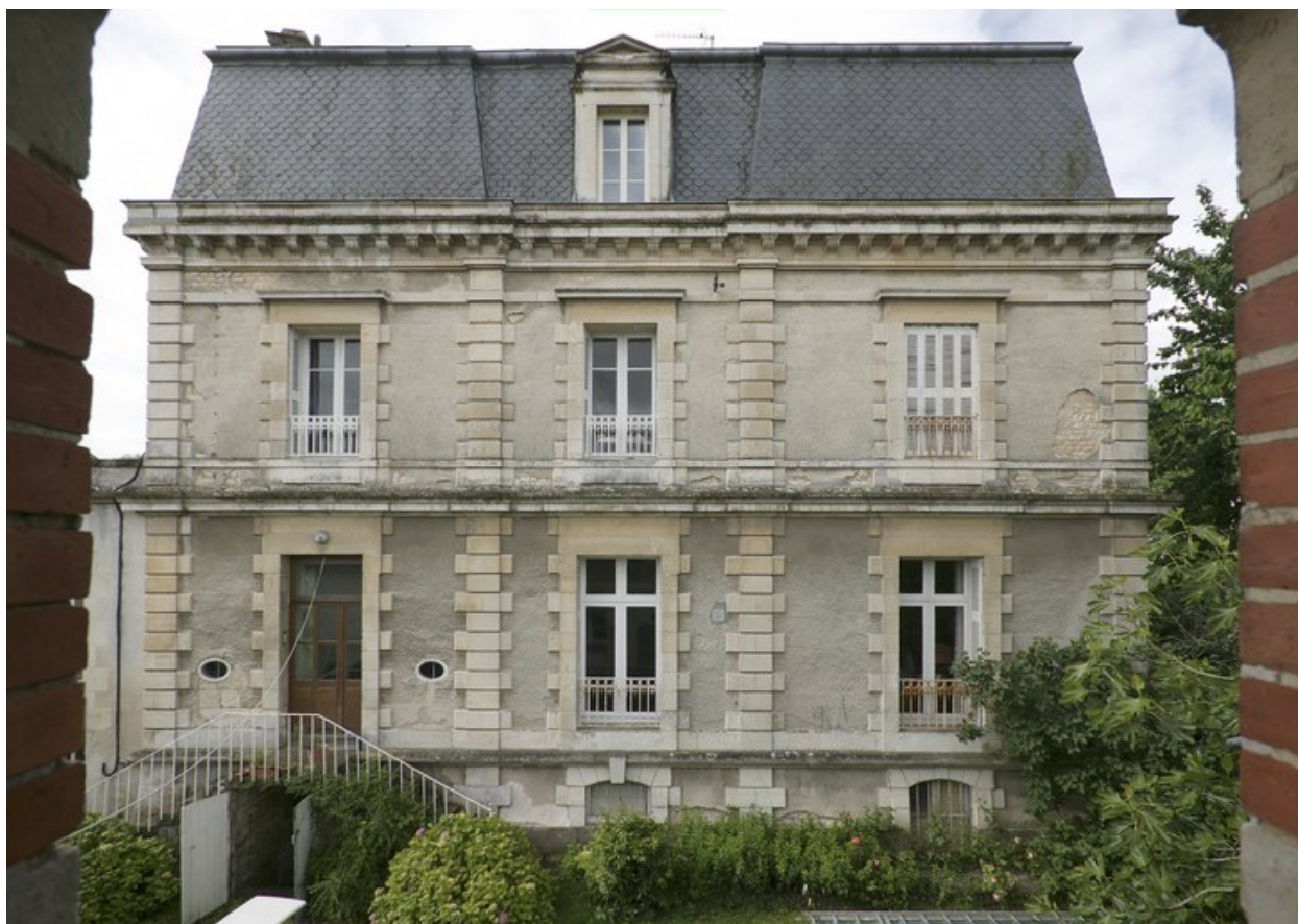
Vue de la façade arrière.
