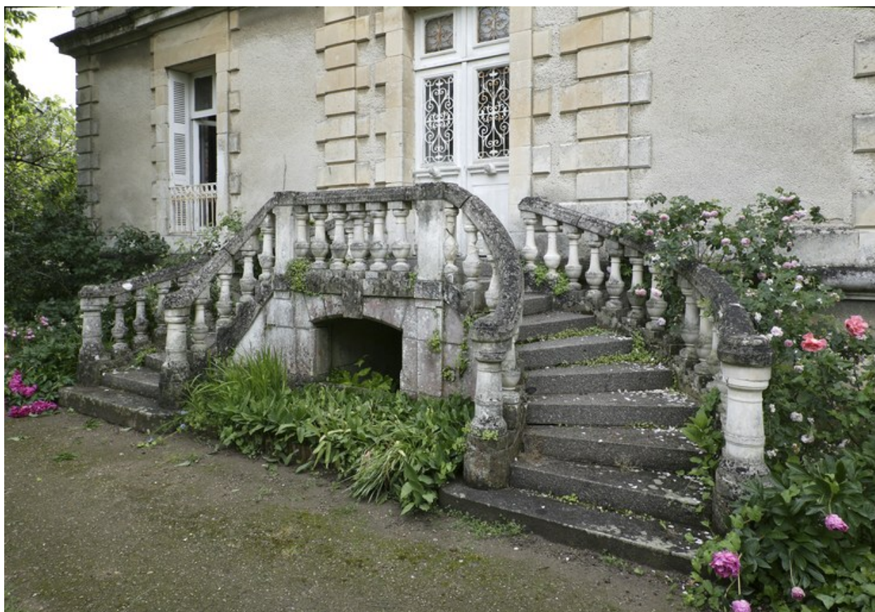
Escalier extérieur de la façade ouest.
