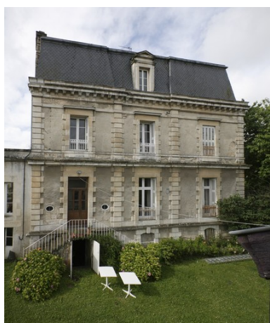
Vue de la façade arrière. Phot. Patrice Giraud IVR52_20088500877NUCA
