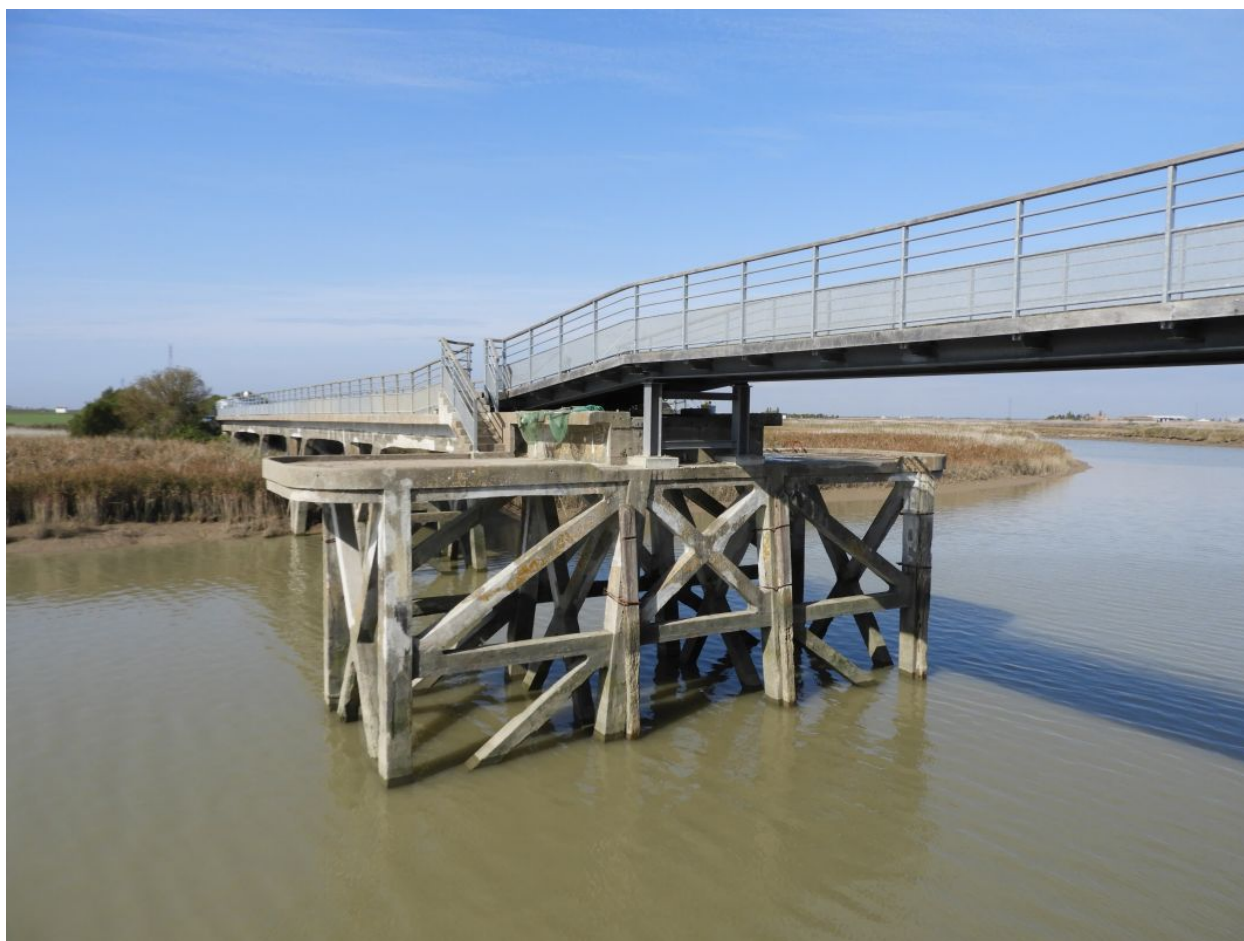
La partie ouest du pont, rive droite, côté Vendée, sous la passerelle de 2012, vue depuis le sud-est.
