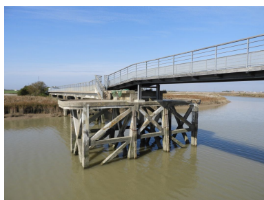
La partie ouest du pont, rive droite, côté Vendée, sous la passerelle de 2012, vue depuis le sud-est. Phot. Yannis Suire IVR52_20188500405NUCA
