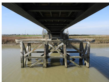
VUe sous la passerelle de 2012, en direction de l'ouest. Phot. Yannis Suire IVR52_20188500408NUCA
