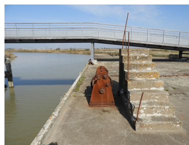
Vestiges du système de manoeuvre du tablier mobile, sur l'éperon de la rive gauche. Phot. Yannis Suire IVR52_20188500406NUCA
