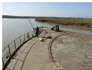
Eperon de la rive gauche du pont, côté aval, avec le rail de l'ancien tablier tournant. Phot. Yannis Suire IVR52_20188500404NUCA
