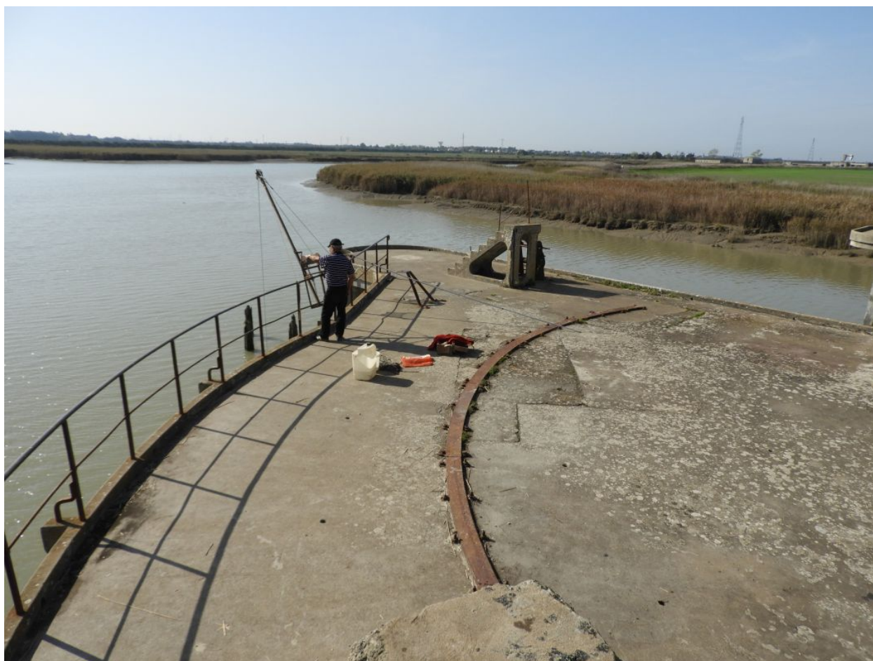
Eperon de la rive gauche du pont, côté aval, avec le rail de l'ancien tablier tournant.
