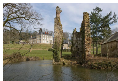
La maison-forte : vue d'ensemble depuis le sud-ouest. Phot. Yves Guillotin IVR52_20105300231NUCA
