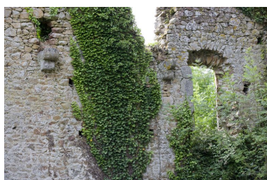
La maison-forte : vue de détail de la fenêtre du 2e niveau et des consoles qui supportaient la galerie du 3e niveau, depuis le nord-ouest. Phot. Yves Guillotin IVR52_20095300313NUCA
