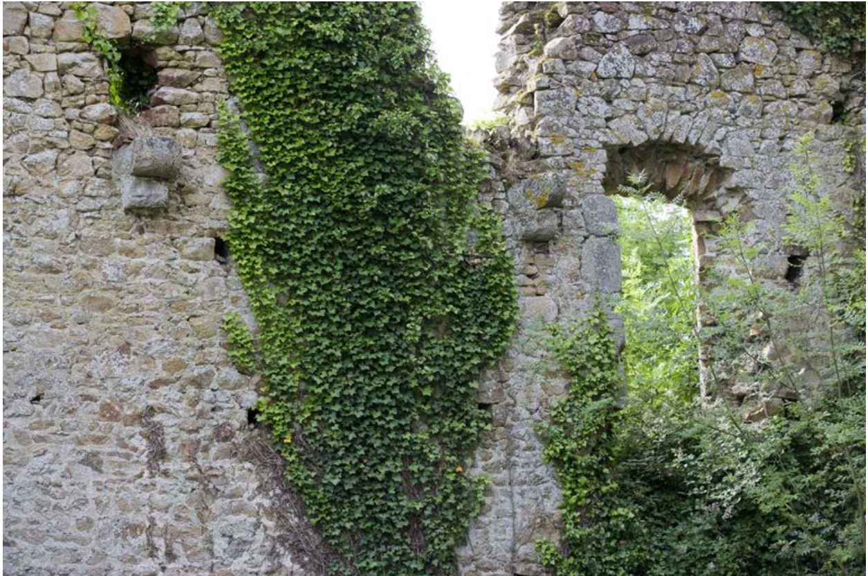
La maison-forte : vue de détail de la fenêtre du 2e niveau et des consoles qui supportaient la galerie du 3e niveau, depuis le nord-ouest.
