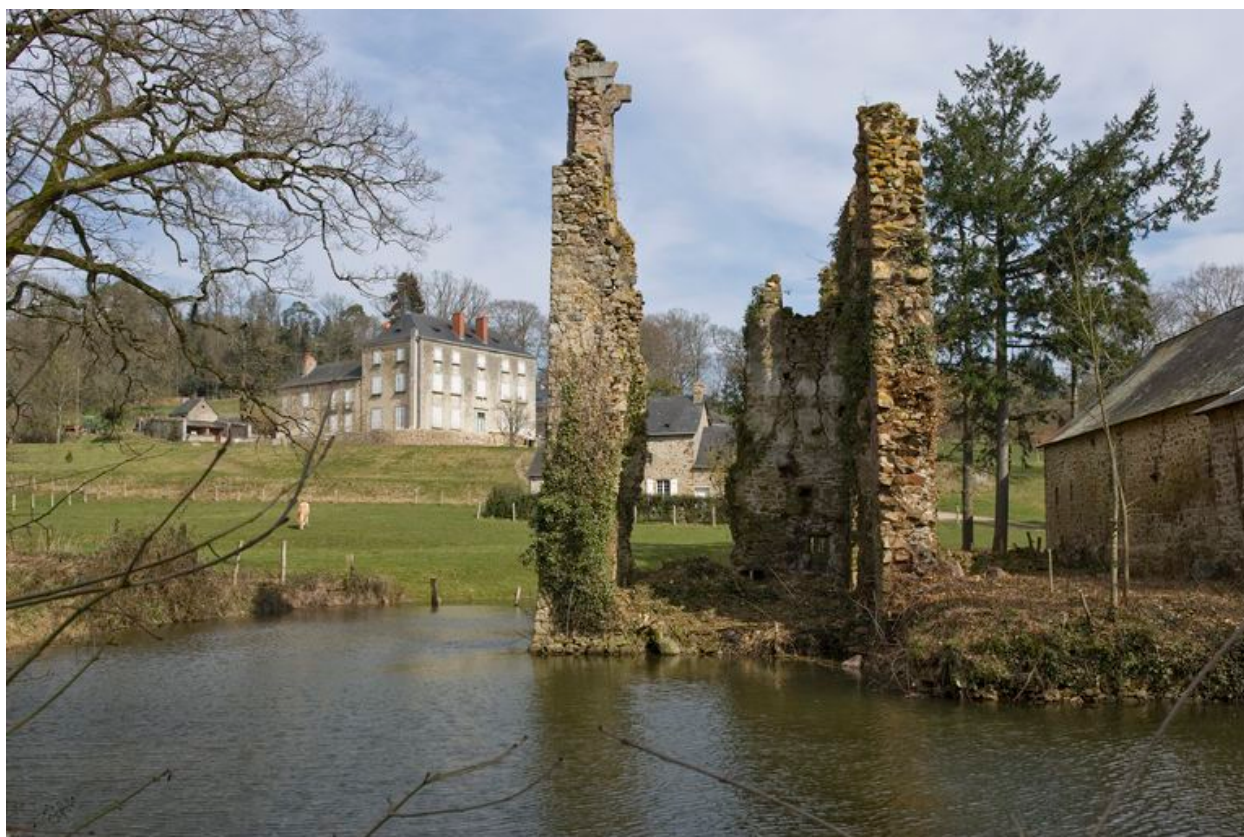
La maison-forte : vue d'ensemble depuis le sud-ouest.
