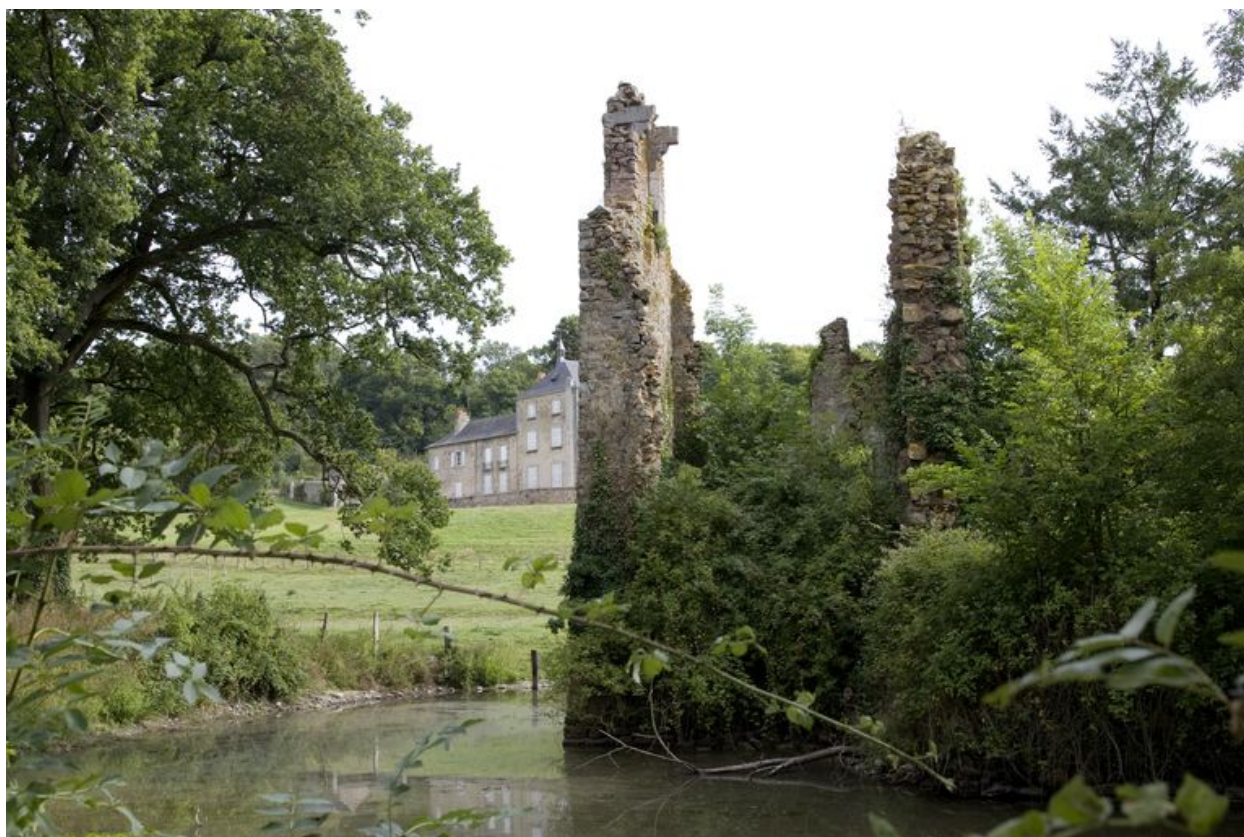
La maison-forte : la tour carrée vue depuis le sud-ouest.
