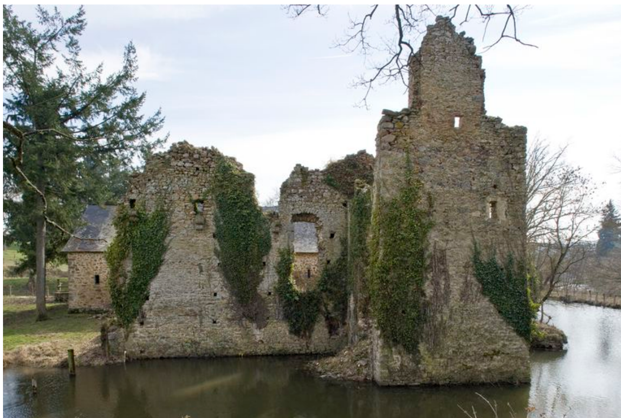
La maison-forte : vue d'ensemble depuis le nord-ouest.
