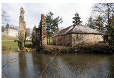
La maison-forte : vue d'ensemble depuis le sud-ouest. Phot. Yves Guillotin IVR52_20105300228NUCA
