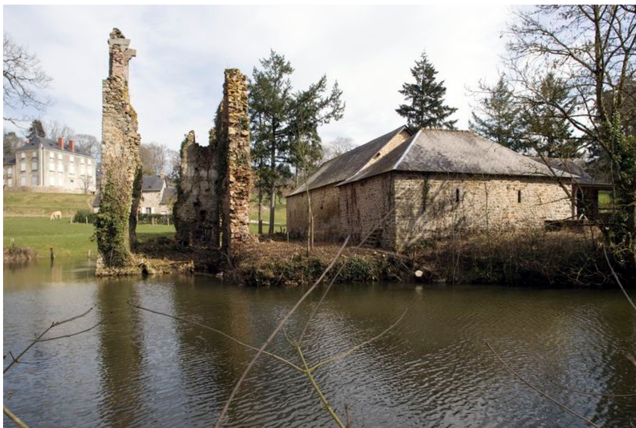
La maison-forte : vue d'ensemble depuis le sud-ouest.
