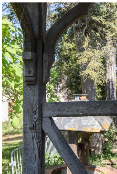
Pavillon de jardin. Détail du poteau cornier et de la balustrade. Phot. Armelle Maugin IVR52_20254900736NUCA
