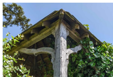
Pavillon de jardin. Détail du poteau cornier. Phot. Armelle Maugin IVR52_20254900737NUCA
