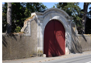
Vue du portail d'entrée depuis la rue. Phot. Armelle Maugin IVR52_20254900740NUCA
