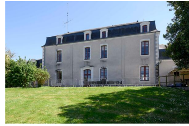
Vue de la façade nord. Phot. Armelle Maugin IVR52_20254900738NUCA
