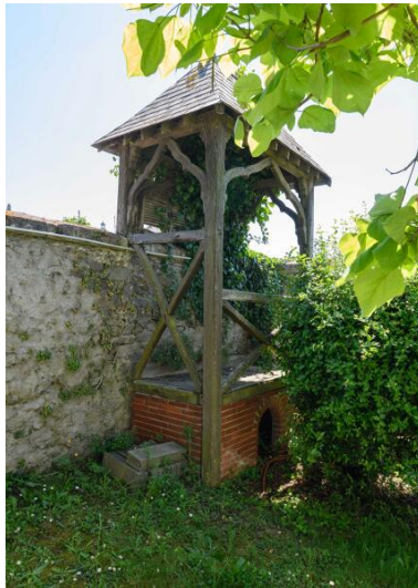
Pavillon de jardin. Vue d'ensemble. Phot. Armelle Maugin IVR52_20254900734NUCA
