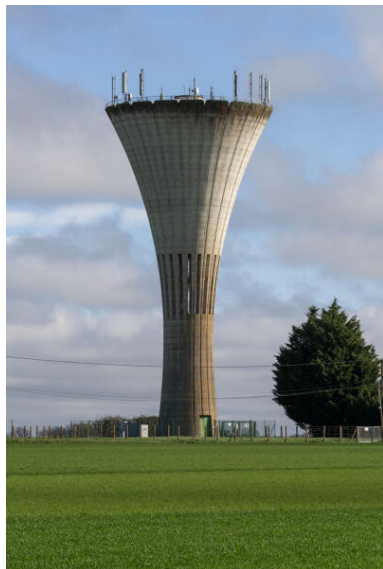
Vue d'ensemble. Phot. Jeanne Minier IVR52_20267200239NUCA
