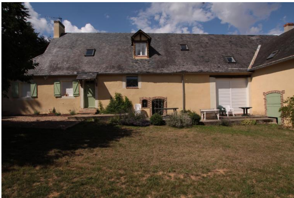
Maison et anciennes dépendances : façade sur cour.
