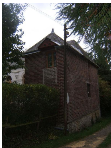
Dépendance en brique noire accolée à la précédente. Phot. Stéphanie Aquilon IVR52_20097202109NUCA
