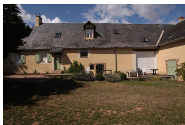
Maison et anciennes dépendances : façade sur cour. Phot. Jean-Baptiste Darrasse IVR52_20107201559NUCA
