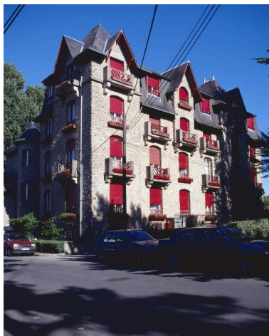
Détail du pignon ouest de l'hôtel Castel Marie-Louise. Phot. Denis Pillet IVR52_19964401349XA
