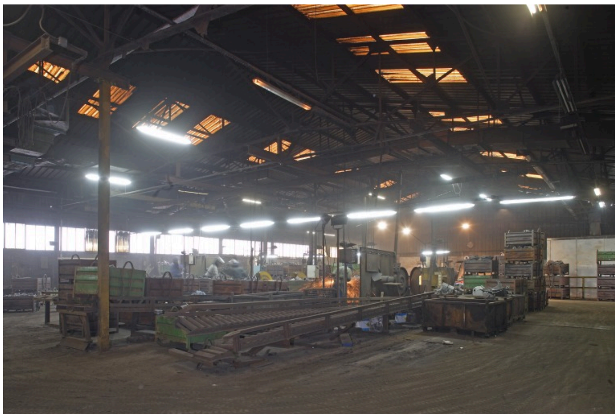
La halle de finition : vue intérieure depuis le nord.
