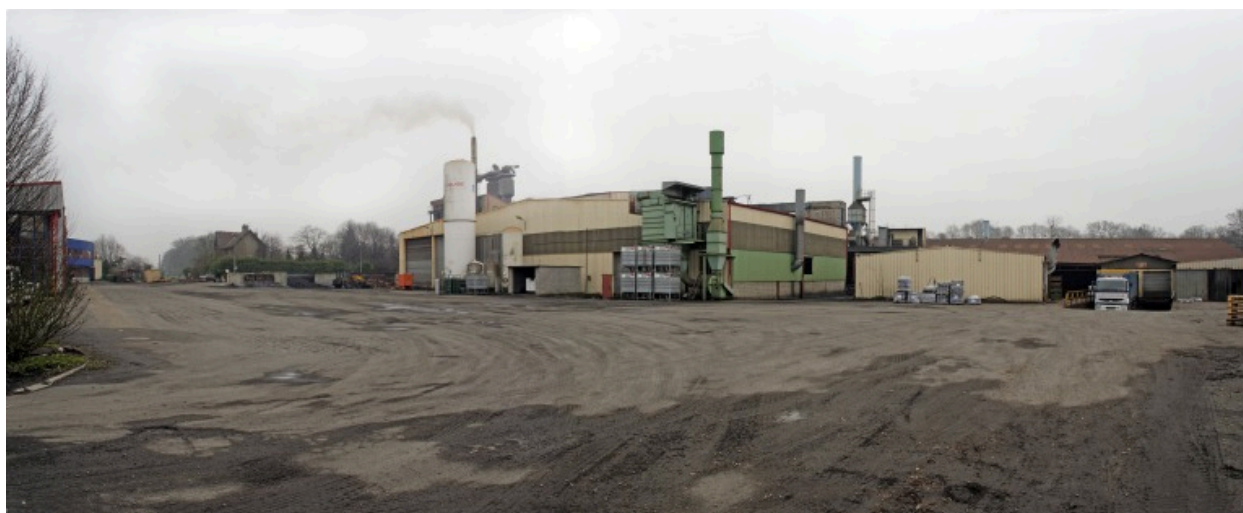
Les bâtiments de production vus depuis le sud-ouest.
