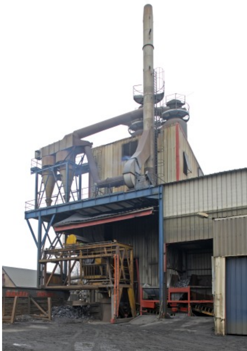
Les cubilots vus depuis l'ouest.
