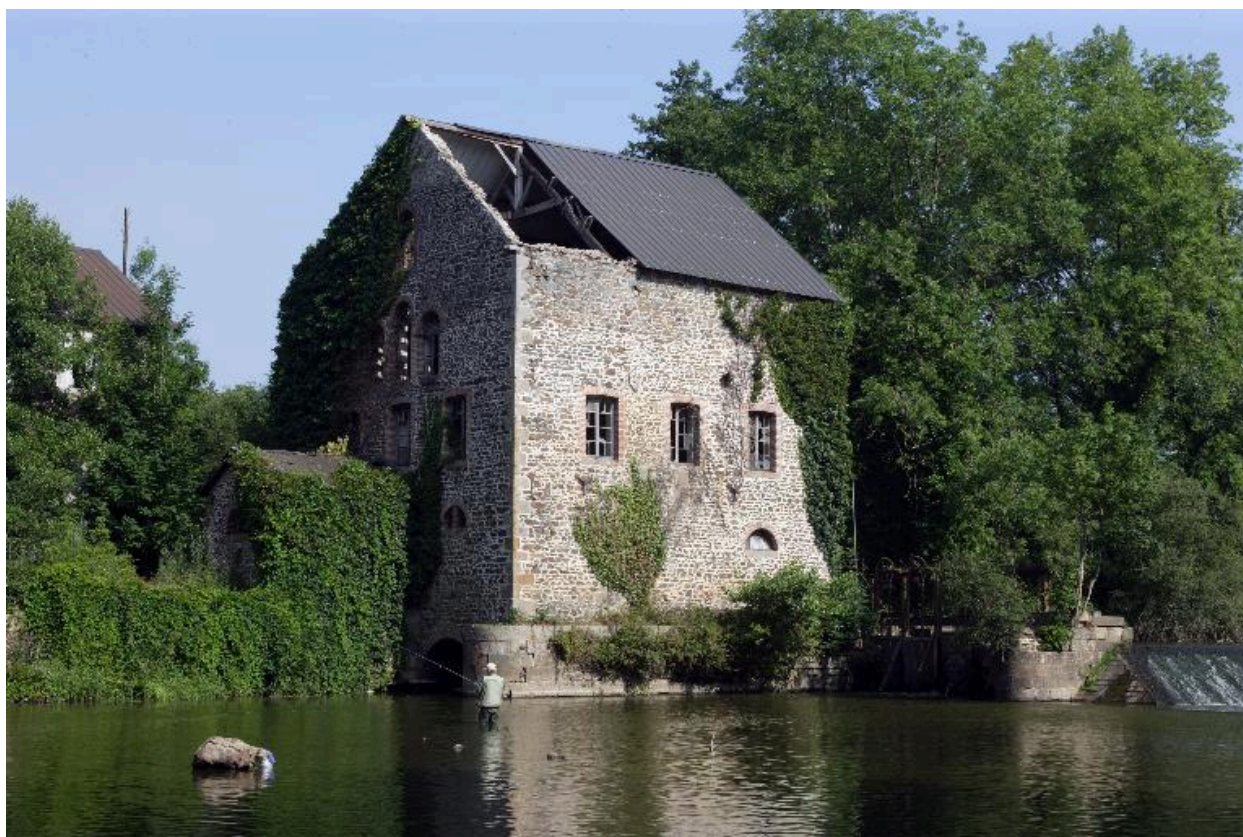
Le moulin à farine vu depuis la rive gauche en aval : élévations sud et est.
