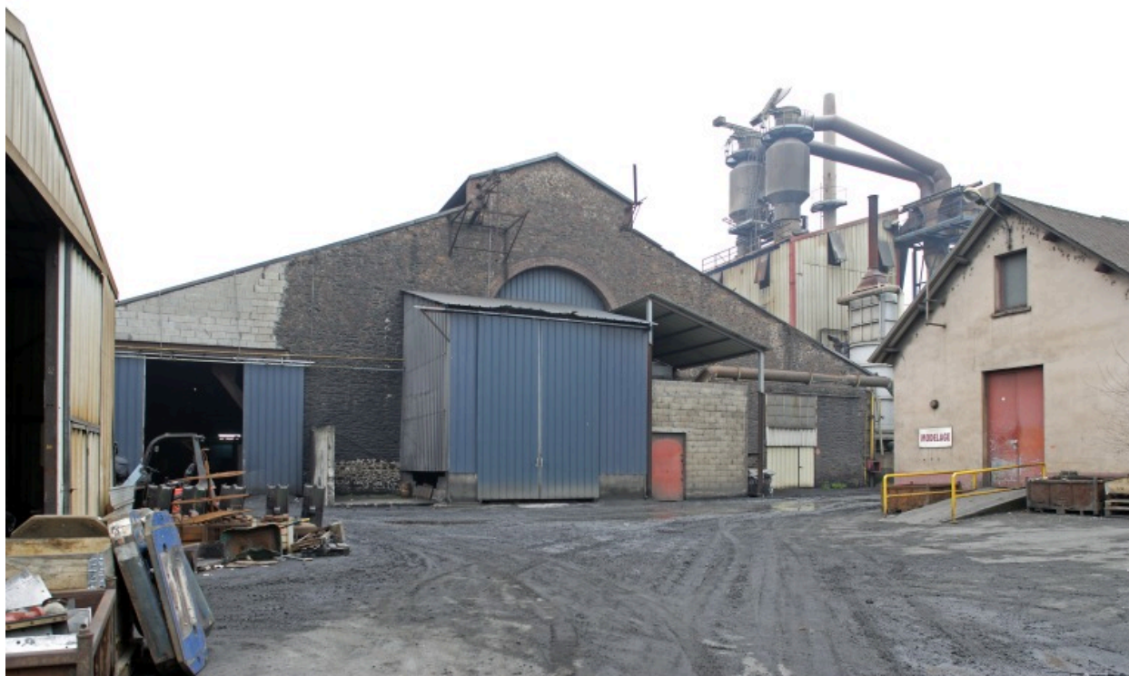
L'élévation nord de la halle de fonderie.
