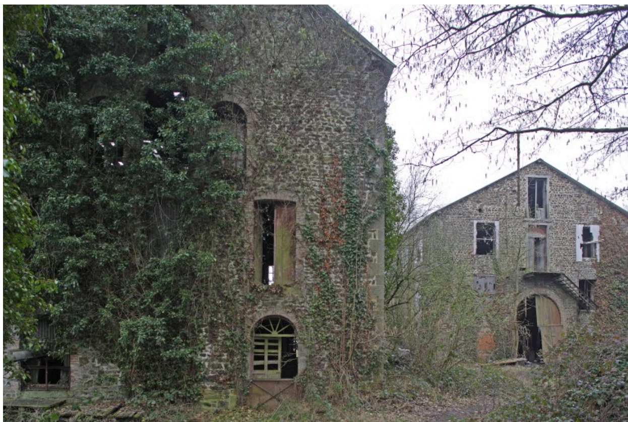
Le moulin à farine et la filature vus depuis la rive droite en amont : élévations nord.
