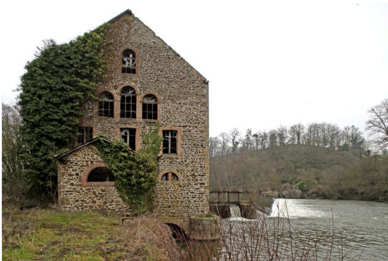
Le moulin à farine vu depuis la rive droite en aval : élévation sud.
