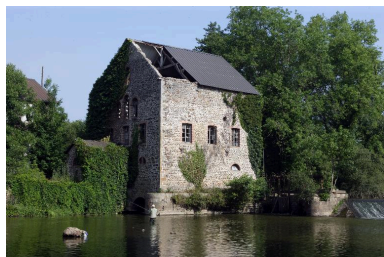
Le moulin à farine vu depuis la rive gauche en aval : élévations sud et est.
