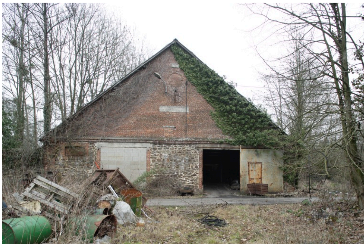
Le magasin : élévation sud.
