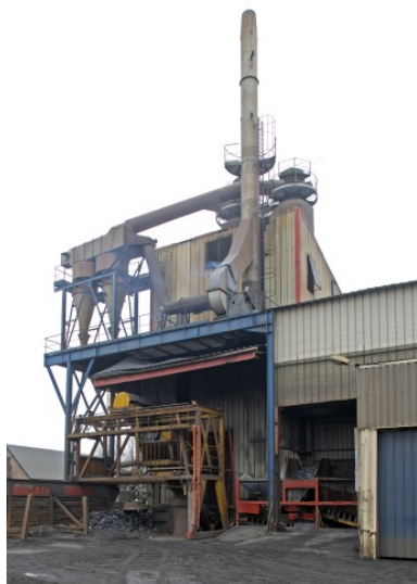
Les cubilots vus depuis l'ouest. Phot. François Lasa IVR52_20065300107NUCA
