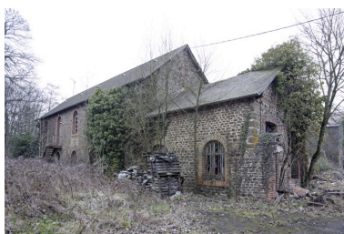
Les anciens bureaux vus depuis le sud-ouest.
