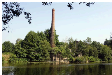
Le bâtiment qui abritait les machines à vapeur vu depuis la rive gauche. Phot. François Lasa
