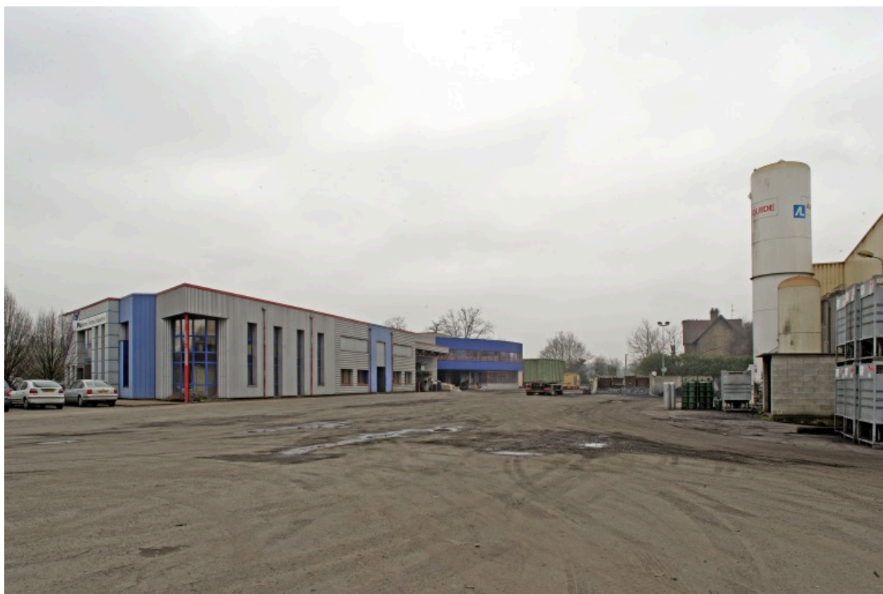
Les bureaux de la fonderie vus depuis le sud-est.
