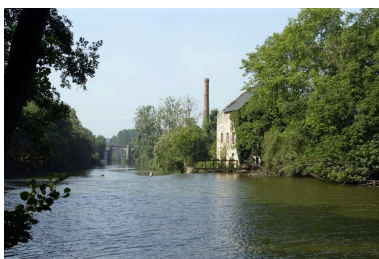
Vue d'ensemble du site du moulin à farine et de la filature depuis la rive gauche en amont.
