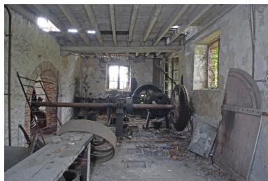
Le moulin à farine, premier étage. La pièce ouest vue depuis le nord : axes et pignons de transmission. Phot. François Lasa IVR52_20065300095NUCA
