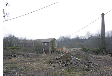
La filature et la cheminée vues depuis l'ouest. Phot. François Lasa IVR52_20065300080NUCA
