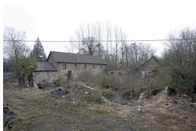
La partie ouest des anciens bâtiments de la filature, vus depuis le sud-
