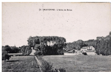
Vue d'ensemble de l'ancien site depuis le sud. De droite à gauche : la minoterie, la filature et des bâtiments aujourd'hui démolis. Autr. E. Chouasnet, Repr. François Lasa IVR52_20065300833NUCA
