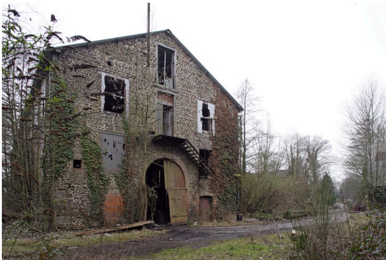
L'élévation nord de la filature.
