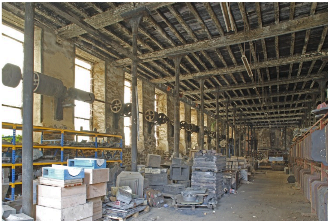
La filature : le rez-de-chaussée vu depuis le nord.
