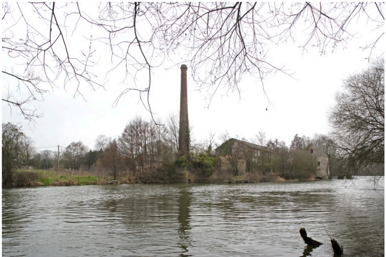
Vue d'ensemble du site du moulin à farine et de la filature depuis la rive gauche en aval.
