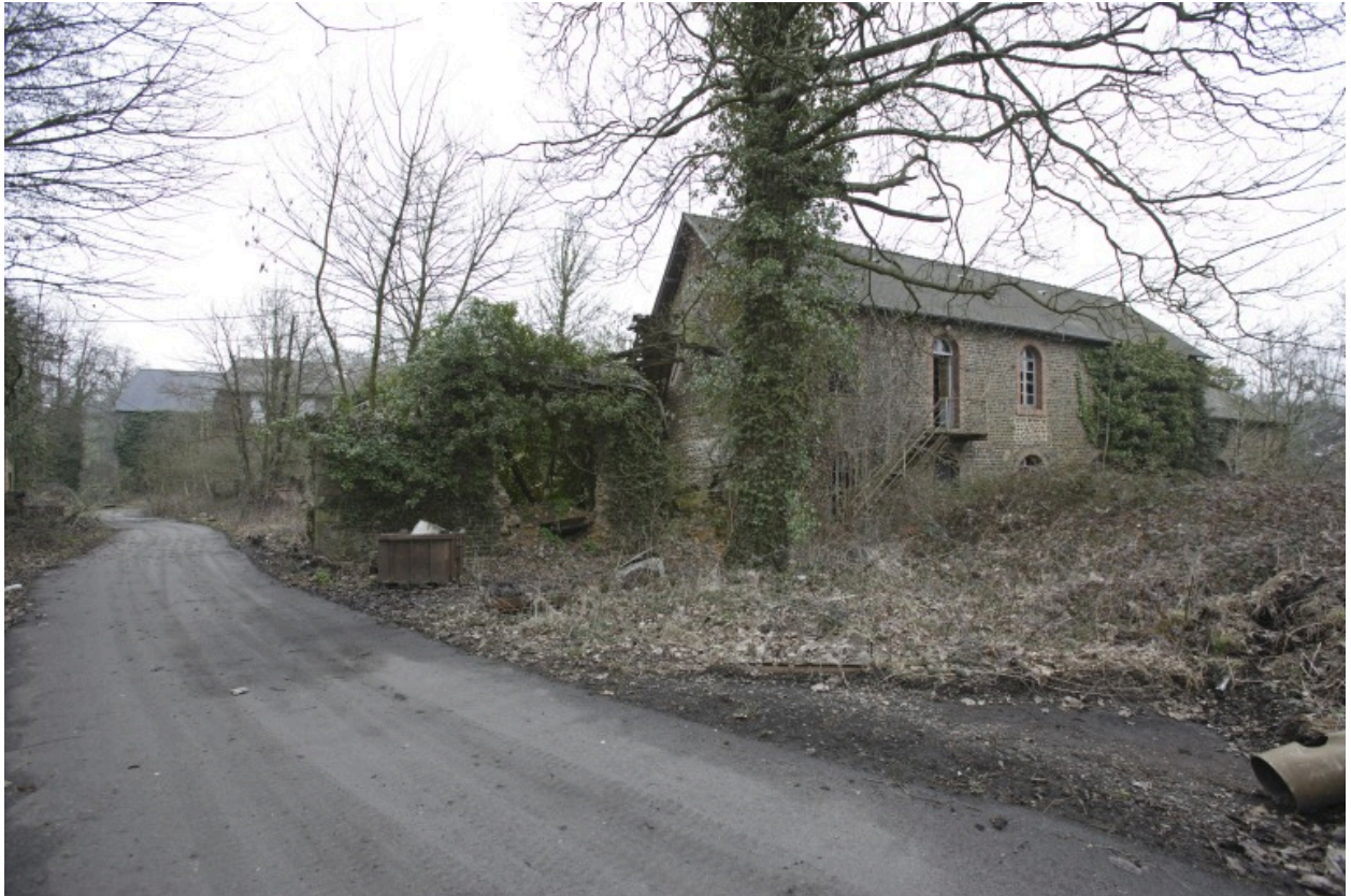
Les anciens bureaux vus depuis le chemin d'accès aux anciens bâtiments à l'ouest.
