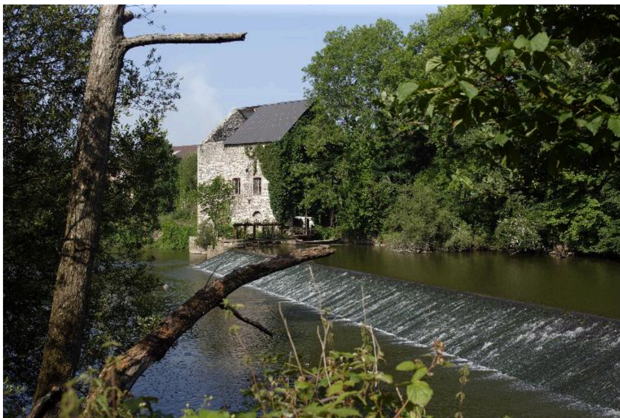
Le moulin à farine et le barrage vus depuis la rive gauche en amont.
