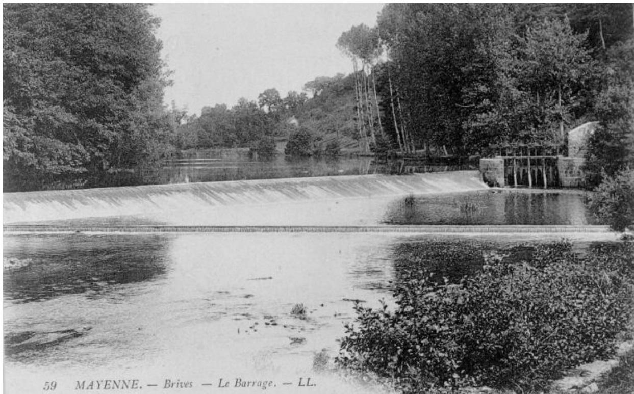
Vue du barrage de Brives.
