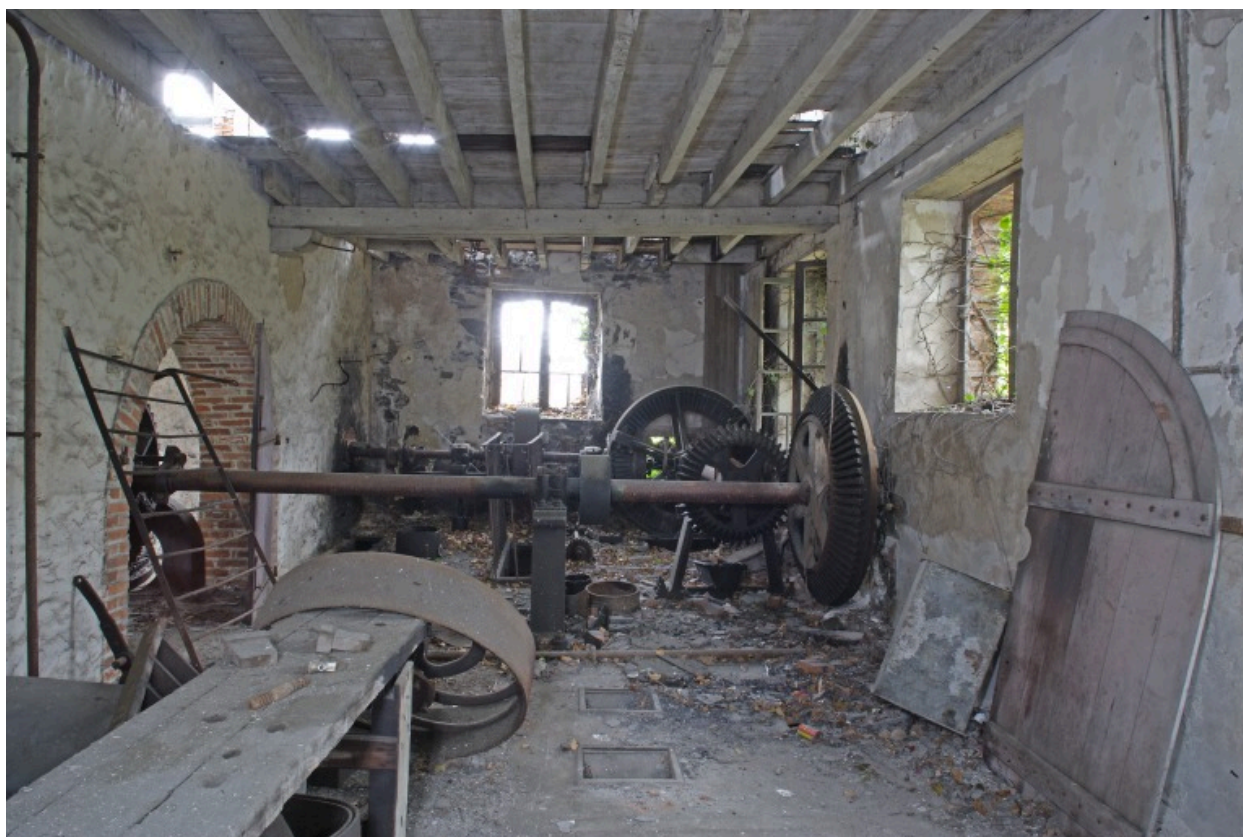
Le moulin à farine, premier étage. La pièce ouest vue depuis le nord : axes et pignons de transmission.
