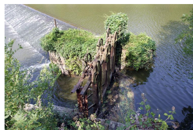
Extrémité est du barrage sur la rive gauche : les vannes de décharge.
