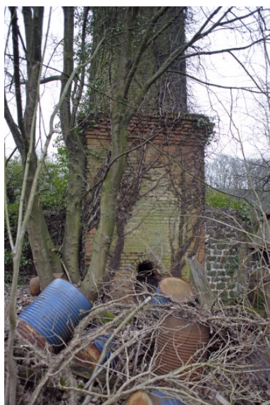
La base de la cheminée vue depuis l'ouest. Phot. François Lasa IVR52_20065300101NUCA
