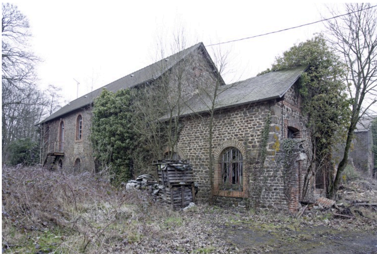
Les anciens bureaux vus depuis le sud-ouest.
