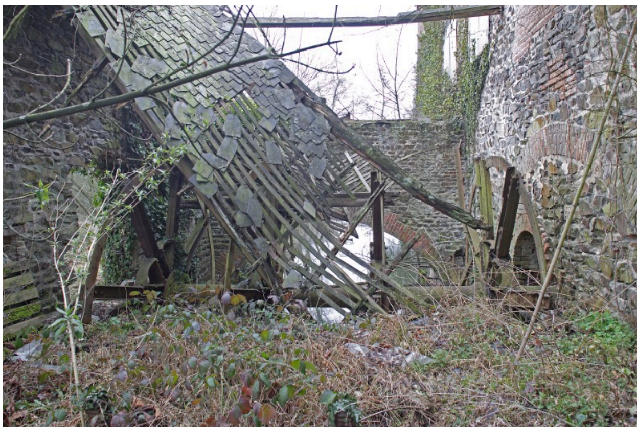
Le coursier et la roue de la filature vus depuis l'amont.
