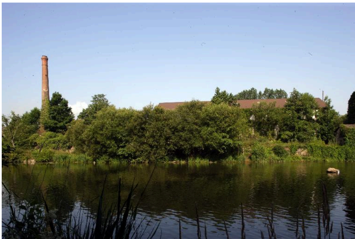
La filature et le bâtiment qui abritait les machines à vapeur, vus depuis la rive gauche.
