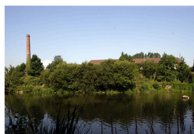
La filature et le bâtiment qui abritait les machines à vapeur, vus depuis la rive gauche. Phot. François Lasa IVR52_20055300367NUCA
