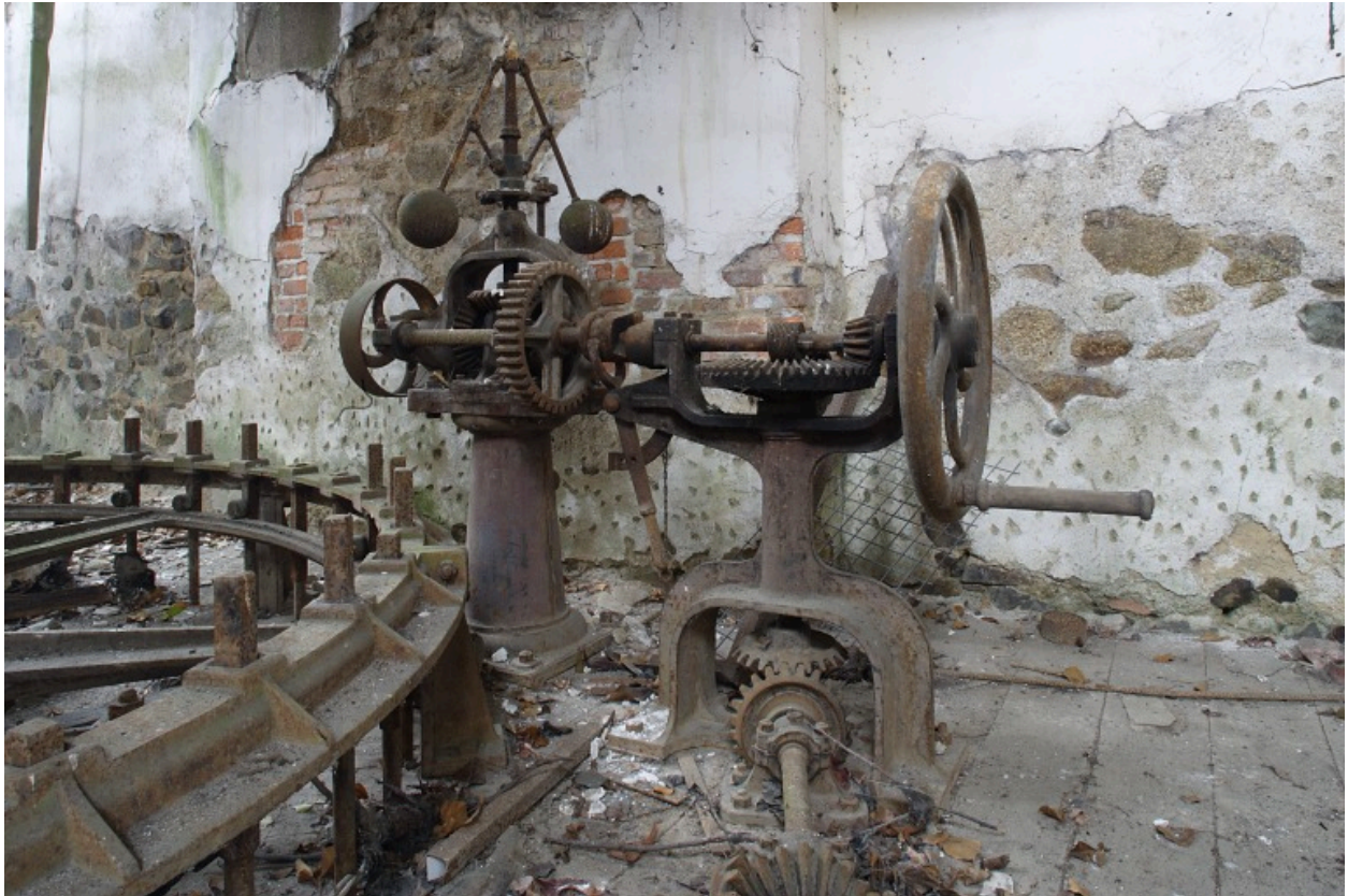
Le moulin à farine, rez-de-chaussée, pièce est : le régulateur de vitesse et le système d'ouverture des vannes de la turbine.
