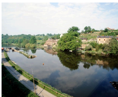
Vue d'ensemble du site depuis le pont de Rochefort, situé en amont : chemin de halage, écluse, canal d'accès à l'écluse, centrale hydroélectrique, barrage, usine néo-métallurgique. Phot. François Lasa
