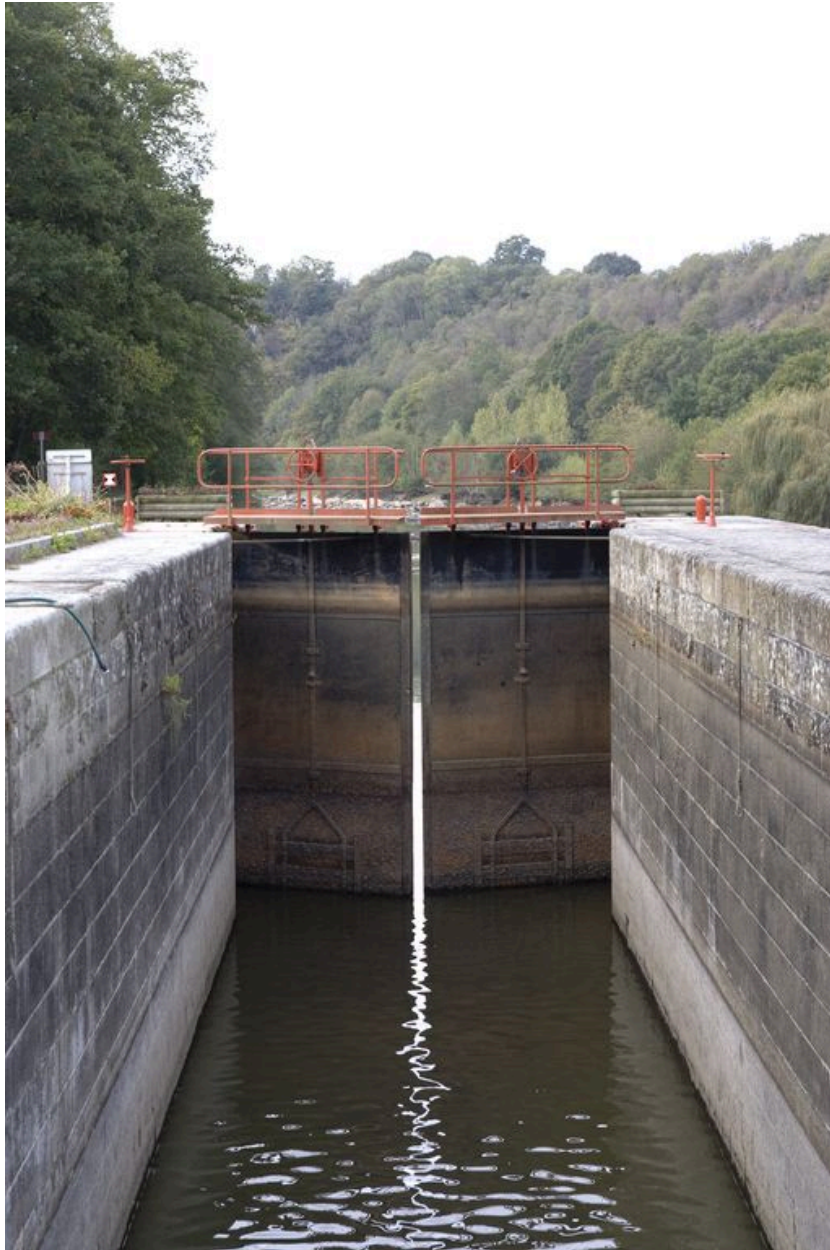
Le sas et la porte d'aval de l'écluse, pendant les écourues de 2009.
