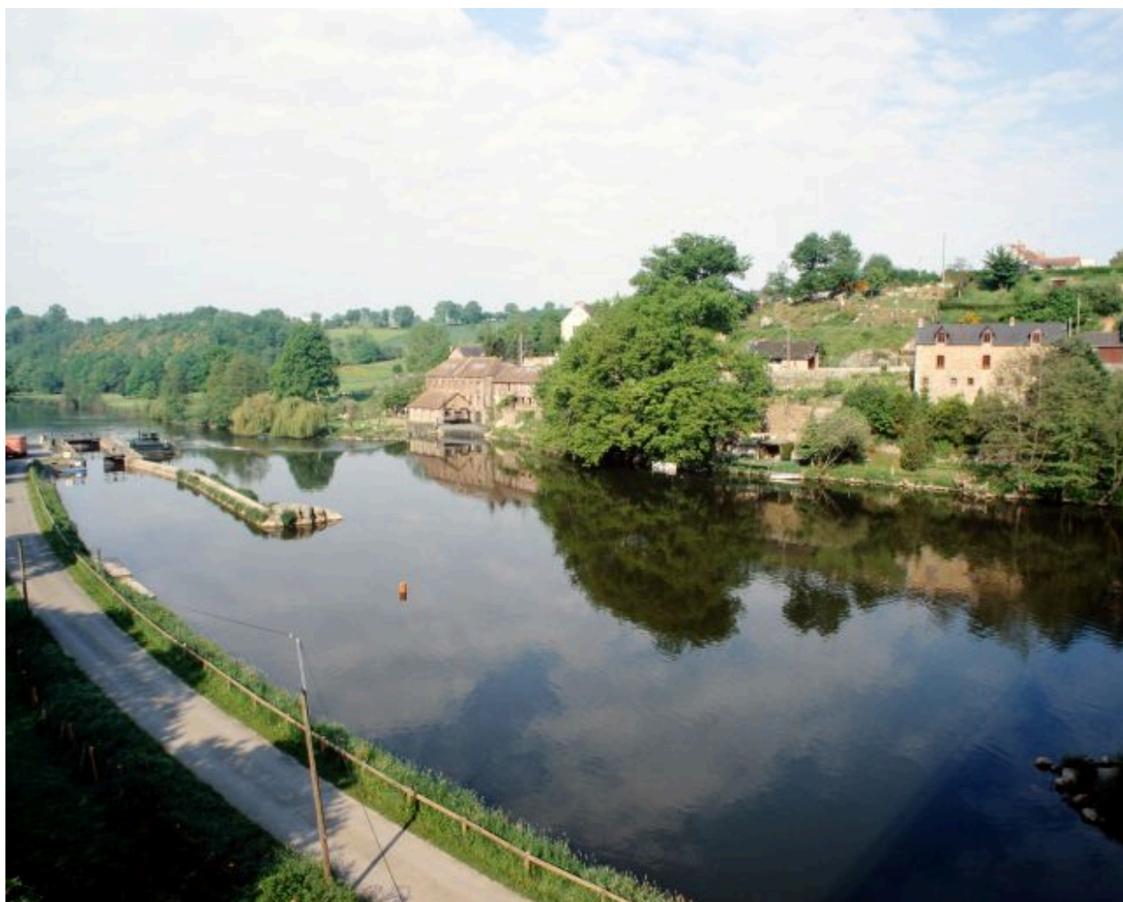
Vue d'ensemble du site depuis le pont de Rochefort, situé en amont : chemin de halage, écluse, canal d'accès à l'écluse, centrale hydroélectrique, barrage, usine néo-métallurgique.
