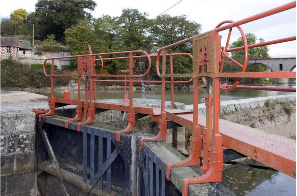
Les garde-corps et les volants actionnant les vannes de la porte d'amont de l'écluse, pendant les écourues de 2009.
