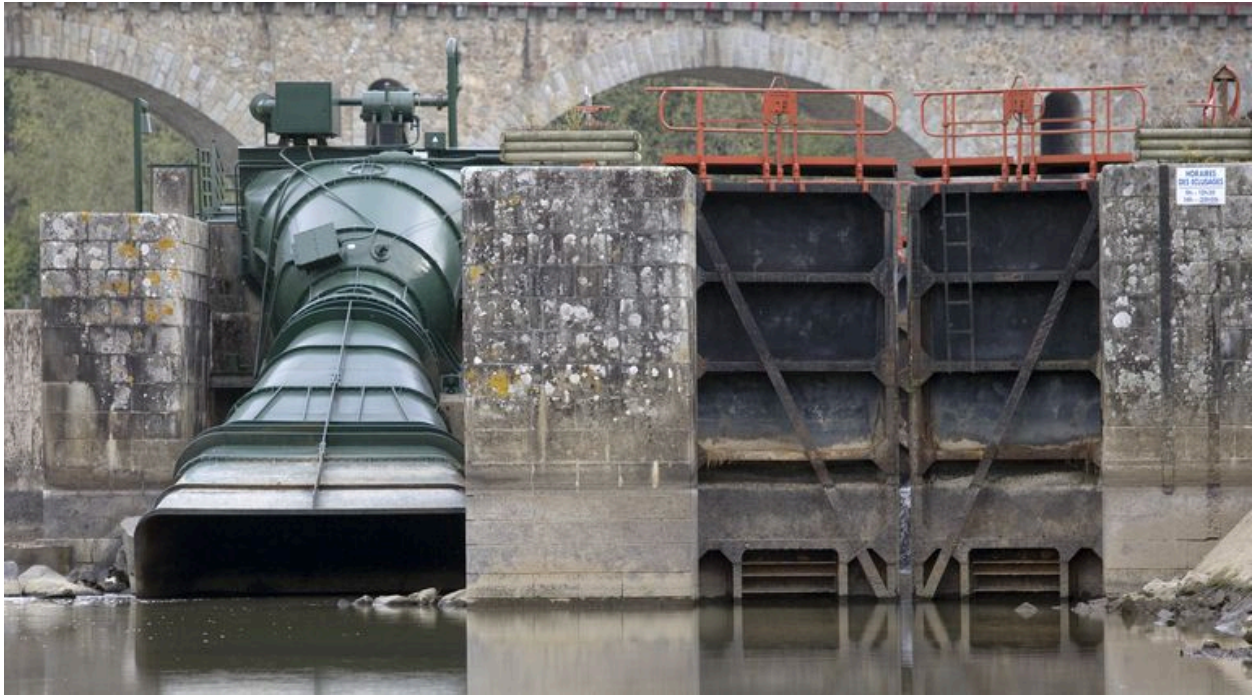
La micro-centrale électrique et l'écluse vues depuis l'aval, pendant les écourées de 2009.
