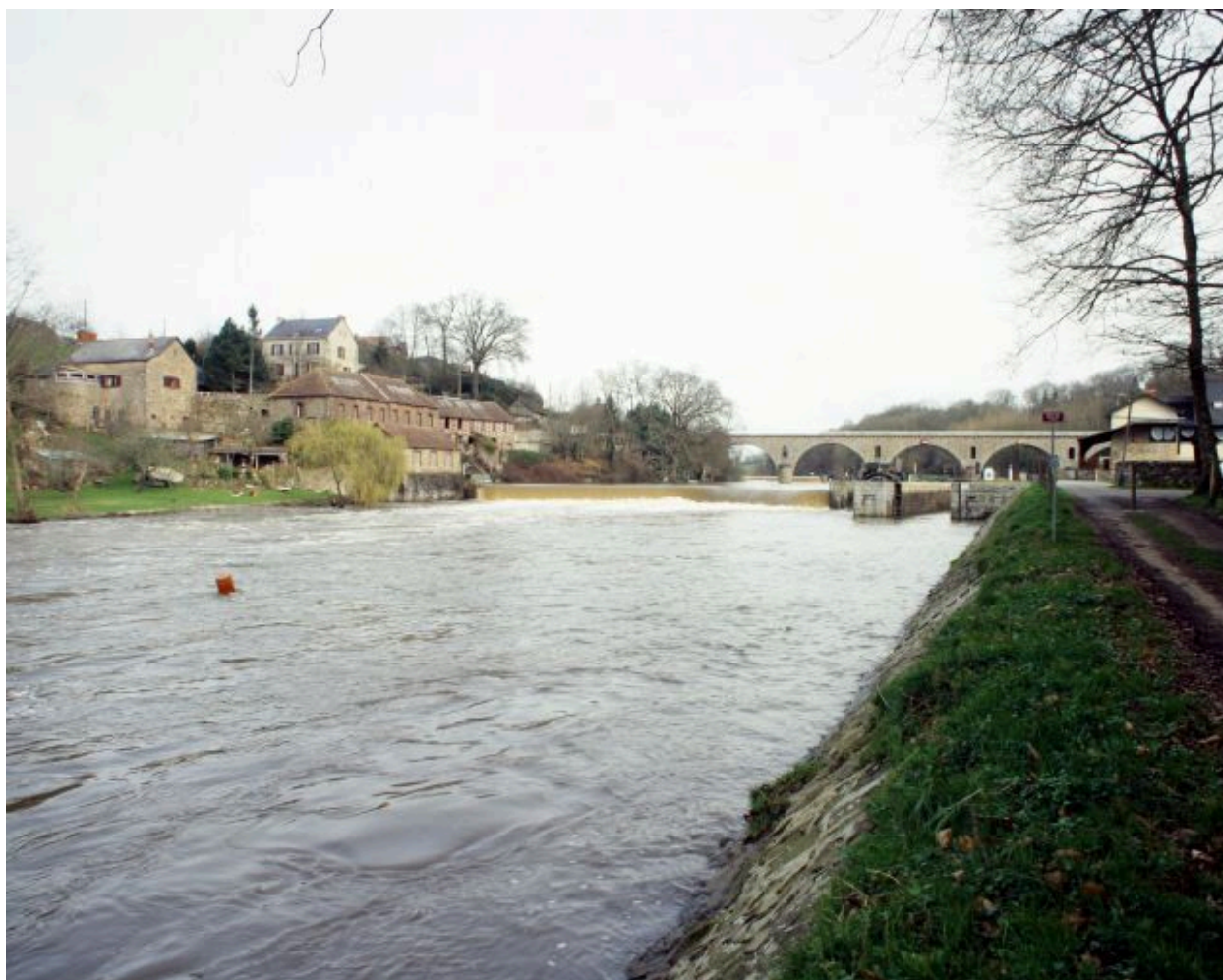
Vue d'ensemble du site depuis la rive gauche, en aval : usine néo-métallurgique, barrage, écluse, maison éclusière.
