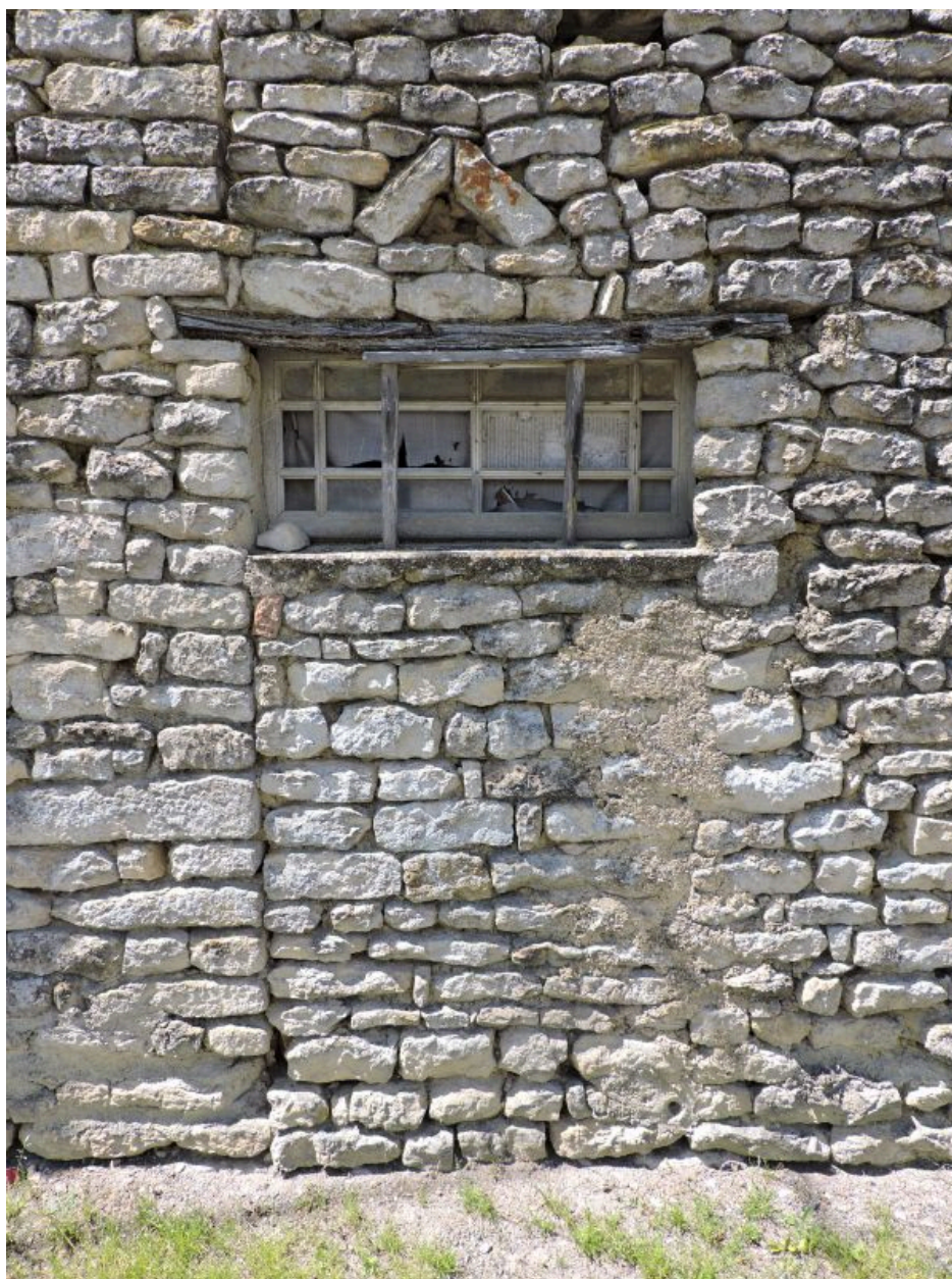
La porte en partie murée, sur le côté de la dépendance.
