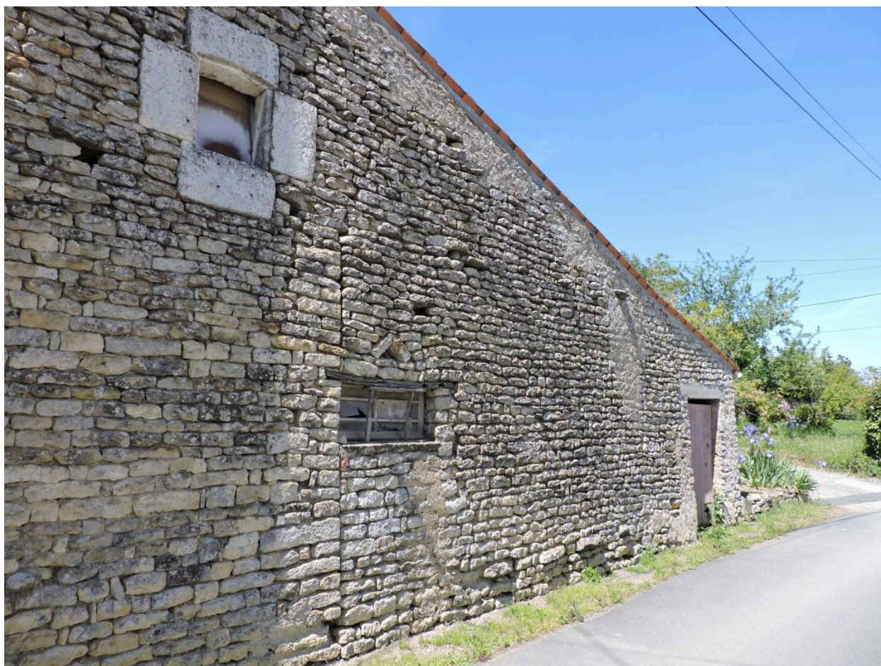
Le mur de côté sud-est de la dépendance et ses ouvertures.
