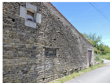
Le mur de côté sud-est de la dépendance et ses ouvertures. Phot. Yannis Suire IVR52_20198501429NUCA
