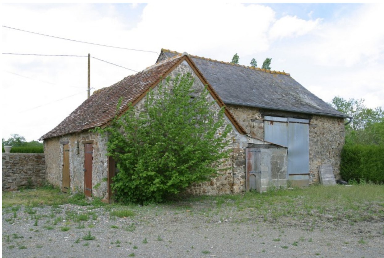
La porcherie et la remise vues depuis la cour.
