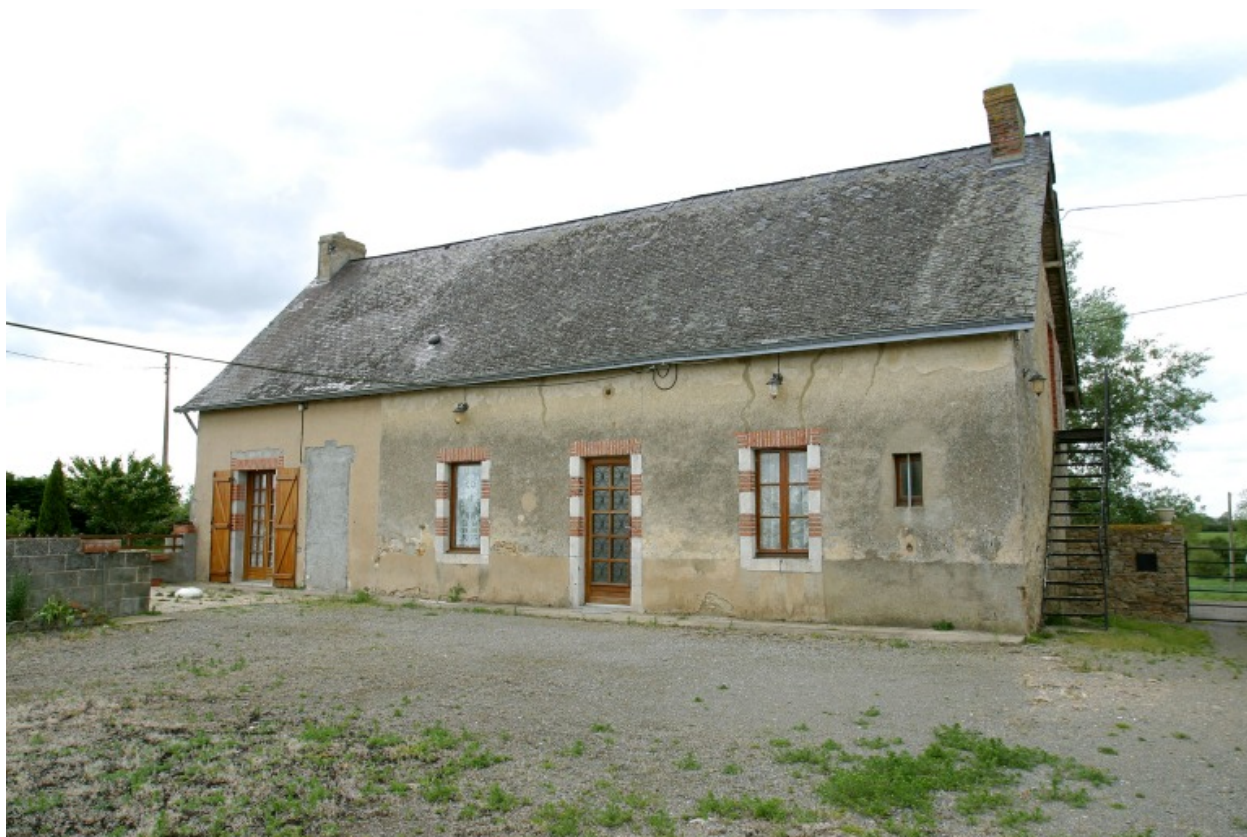
Le logis. Façade principale depuis la cour à l'est.
