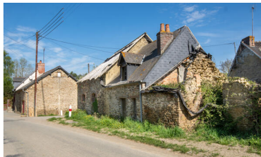
Hameau du Glandsemé (2023 ZM 29). Phot. Pierre-Bernard Fourny IVR52_20225300636NUCA
