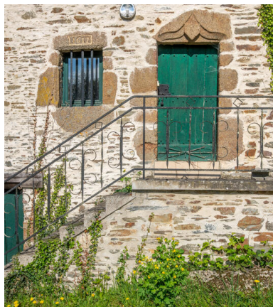
Maison, 9 Glandsemé (2023 ZM 35), date portée 1614. Phot. Pierre-Bernard Fourny IVR52_20225300630NUCA
