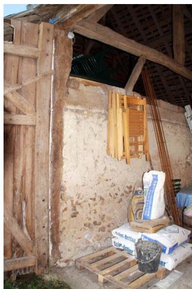
Grange-étable : cloison. Phot. Jean-Baptiste Darrasse IVR52_20097201602NUCA
