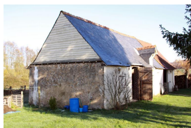
Dépendances. Phot. Jean-Baptiste Darrasse IVR52_20097201601NUCA
