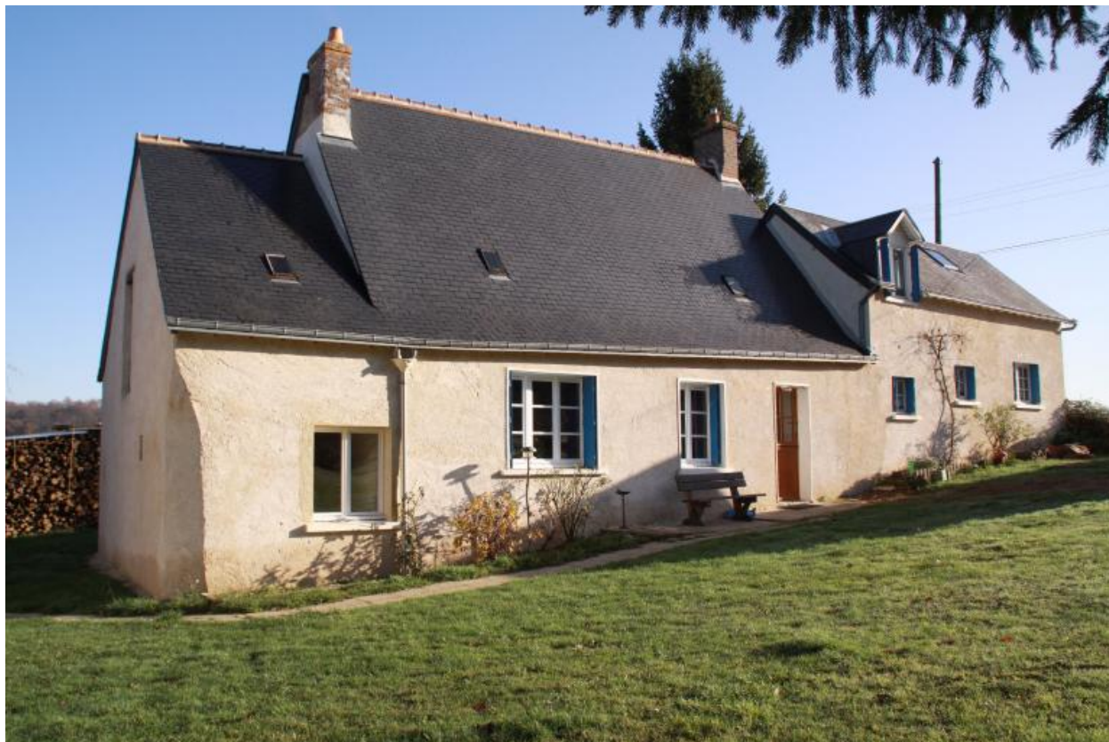
Maison encadrée d'une laiterie et d'un toit à porcs réaménagés.
