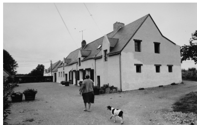
Vue de la façade sud depuis l'est. Phot. Denis (reproduction) Pillet IVR52_20094401441NUC
