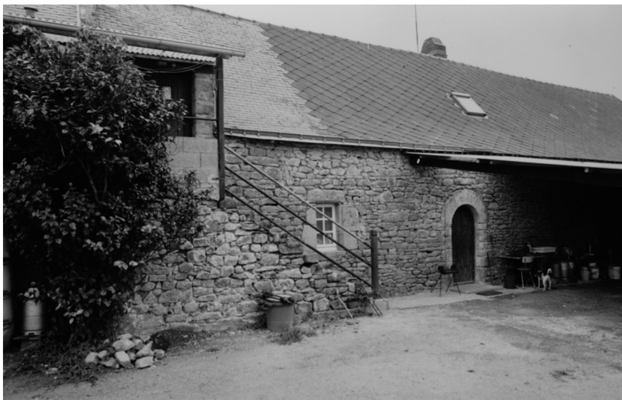
Logis. Façade nord.
