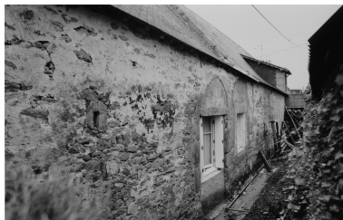
Vue de la façade nord depuis l'est. Phot. Denis (reproduction) Pillet IVR52_20094401439NUC
