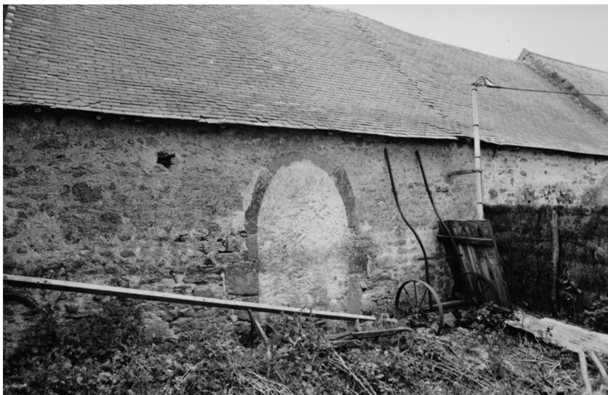
Détail d'une porte en plein cintre. Entrée de grange (?). Façade nord.
