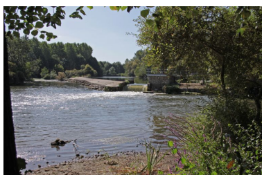
Vue du site et du barrage. Phot. Jean-Baptiste Darrasse IVR52_20097200423NUCA
