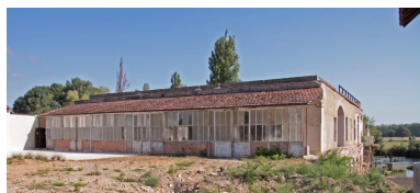
Façade latérale du bâtiment principal, galerie de circulation. Phot. Jean-Baptiste Darrasse IVR52_20097200405NUCA
