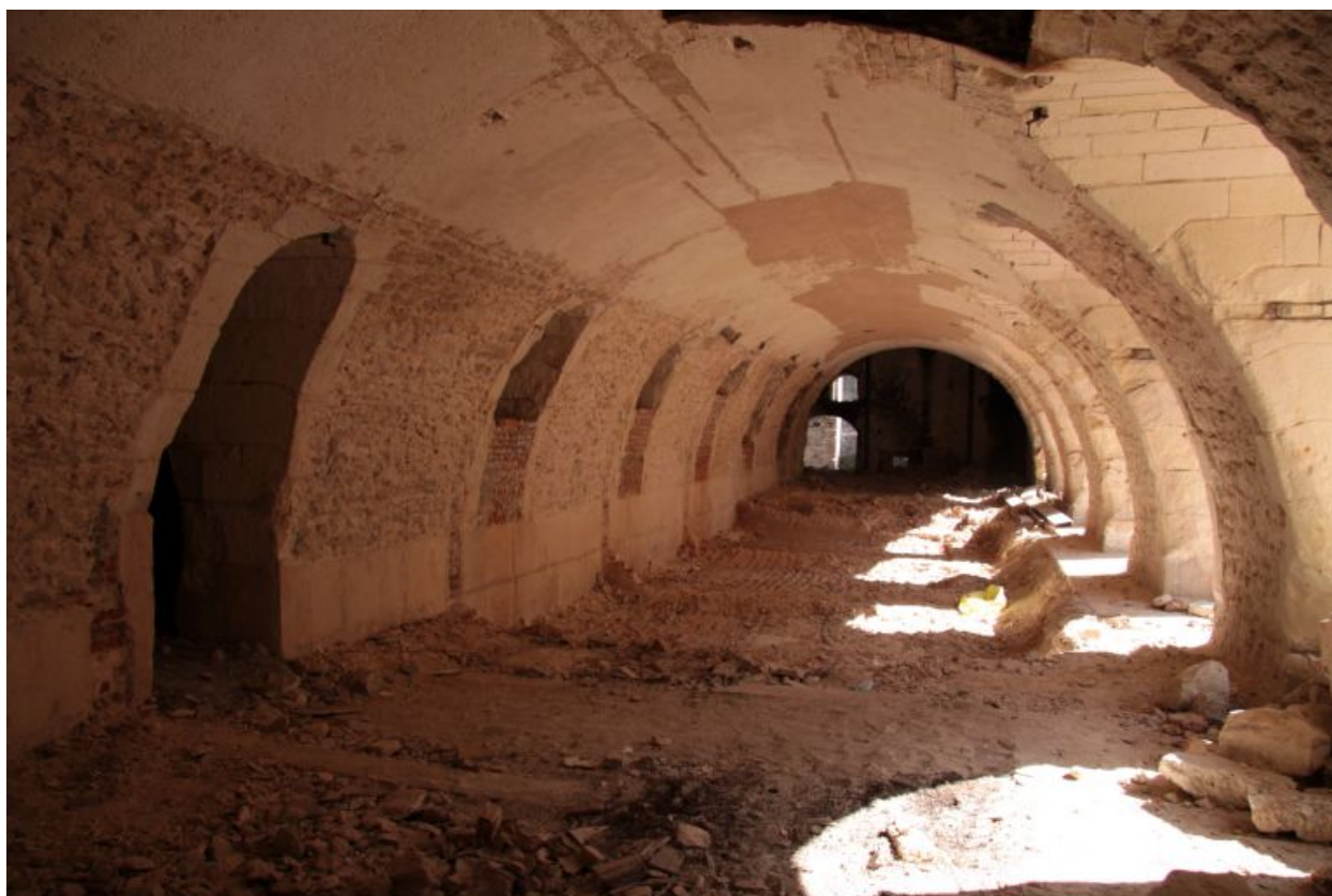
Premier vaisseau, vue générale vers le Loir.
