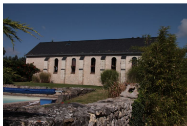
Bâtiment de stockage des matières dangereuses. Phot. Jean-Baptiste Darrasse
