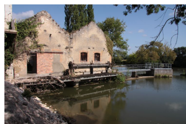
Vue du bâtiment sur le Loir. Phot. Jean-Baptiste Darrasse IVR52_20097200415NUCA
