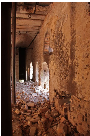
Couloir sur le Loir. Phot. Jean-Baptiste Darrasse IVR52_20097200411NUCA
