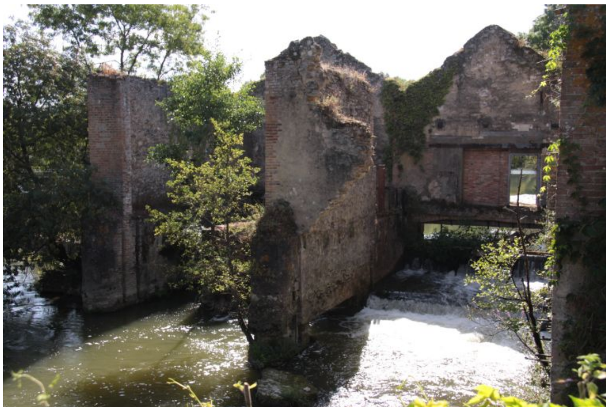
Bâtiment des turbines.
