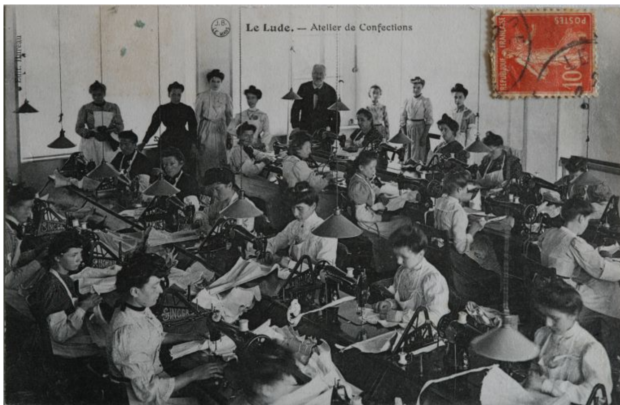
Vue ancienne des ateliers.
