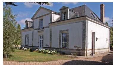
Maison du directeur, vue en volume. Phot. Jean-Baptiste Darrasse IVR52_20097200425NUCA
