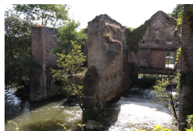
Bâtiment des turbines. Phot. Jean-Baptiste Darrasse IVR52_20097200420NUCA
