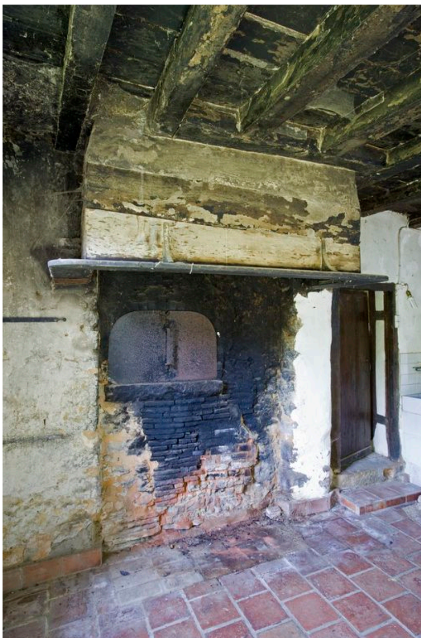
Cheminée du logis du fermier.
