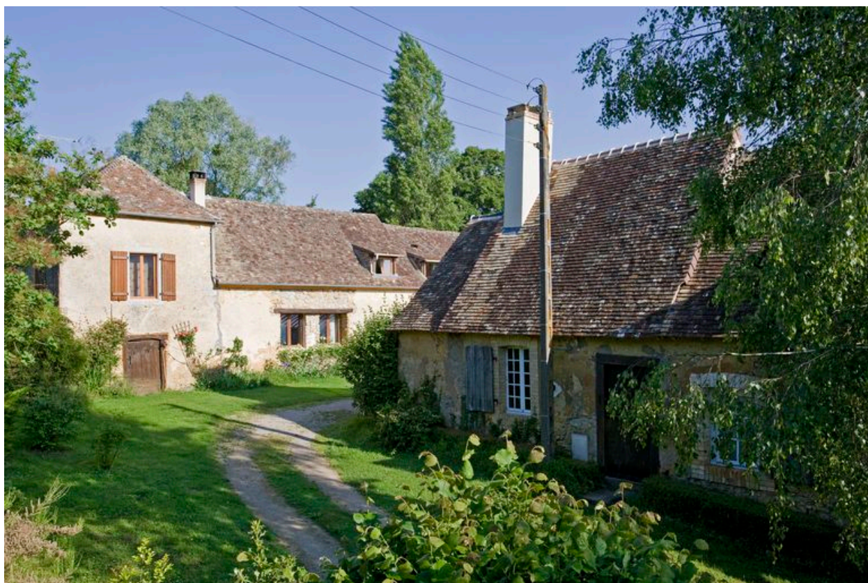
Ensemble depuis l'est.
