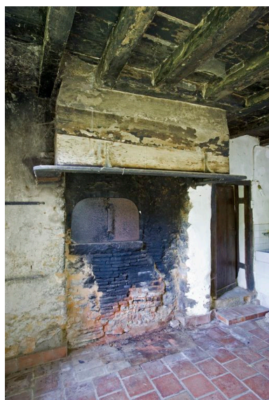
Cheminée du logis du fermier. Phot. Yves Guillotin IVR52_20107202345NUCA
