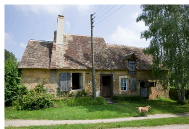
Logis du fermier, élévation sur cour. Phot. Yves Guillotin IVR52_20107202355NUCA
