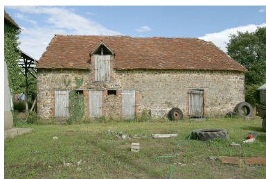
L'étable. Phot. François Lasa IVR52_20035302240NUCA
