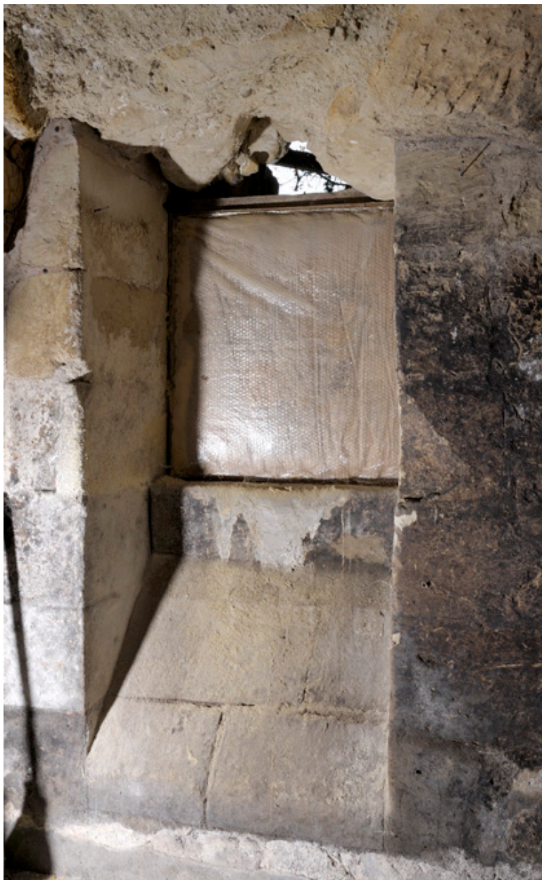
Abri troglodytique sud-est, vue intérieure :détail de la jetée de pressoir.
