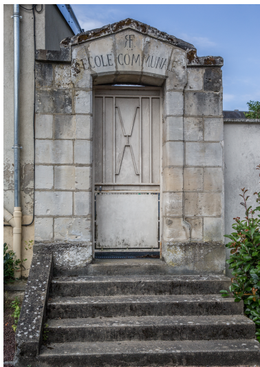
Le portillon. Phot. Pierre-Bernard Fourny IVR52_20187201187NUCA
