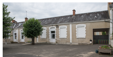
Les classes depuis la cour. Phot. Pierre-Bernard Fourny IVR52_20187201170NUCA
