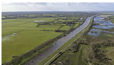
Le canal vers l'aval depuis le site des Champs-Neufs. Phot. Yves Guillotin IVR52_20204400225NUCA
