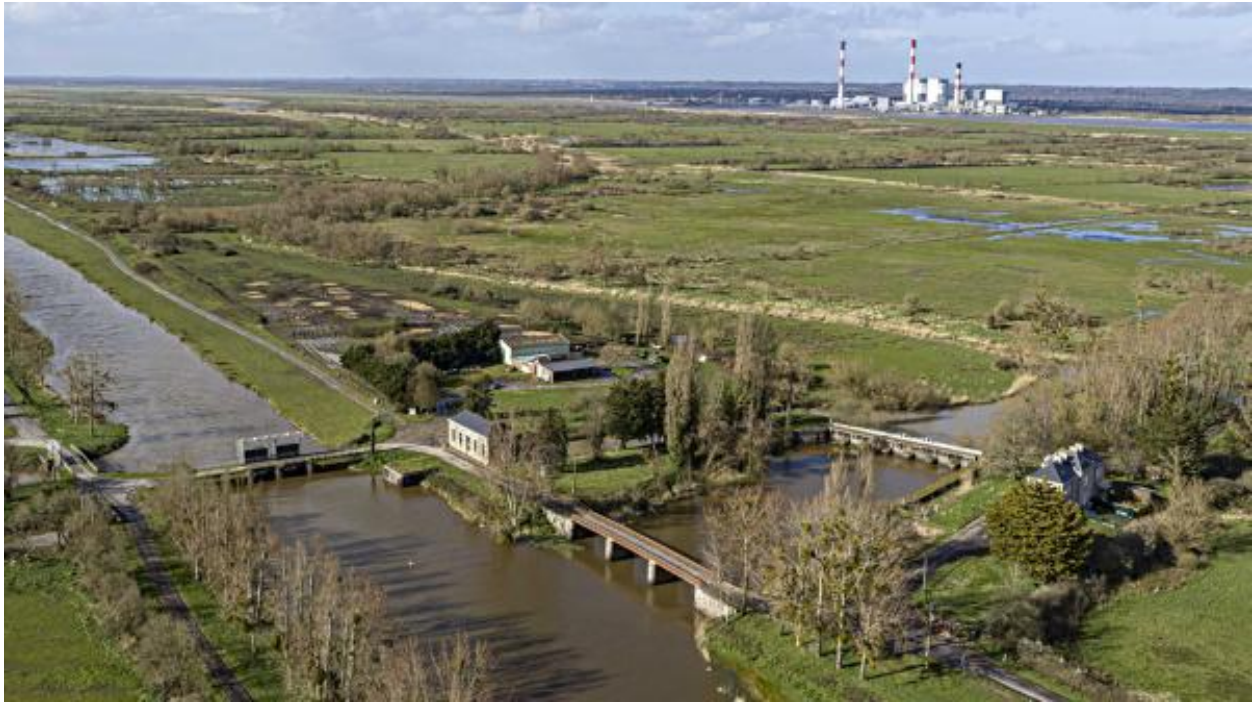
Le canal vers l'aval à la hauteur du site des Champs-Neufs. En arrière-plan, la centrale thermique de Cordemais.
