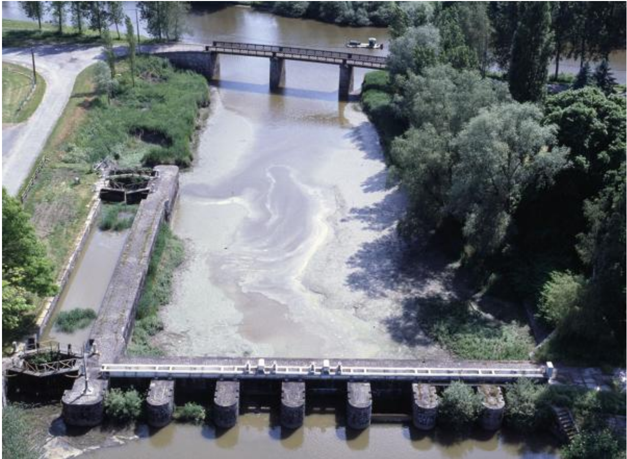
Le barrage des Champs-Neufs, l'écluse de petite navigation et le canal.
