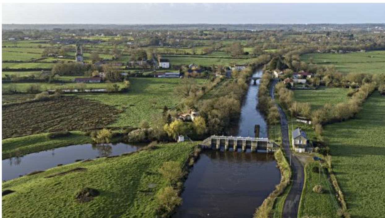
Vue du barrage-écluse de Buzay.
