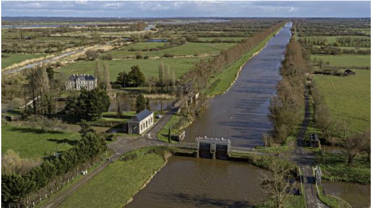
Le canal vers l'amont à la hauteur du site des Champs-Neufs.
