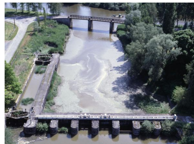
Le barrage des Champs-Neufs, l'écluse de petite navigation et le canal. Phot. Denis Pillet IVR52_20004402053XA
