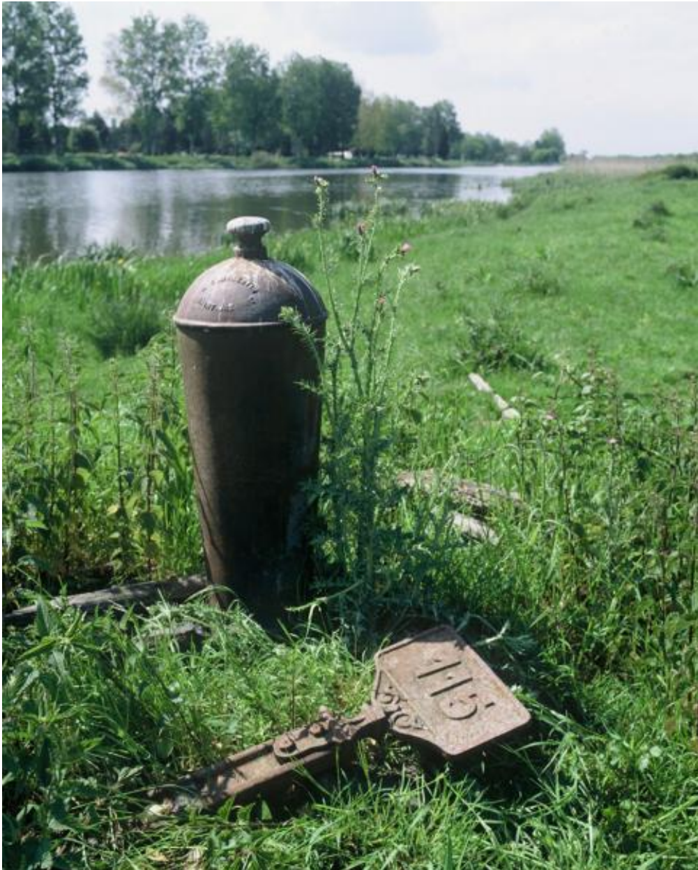
Détail d'une borne d'amarrage et d'une borne hectométrique.
