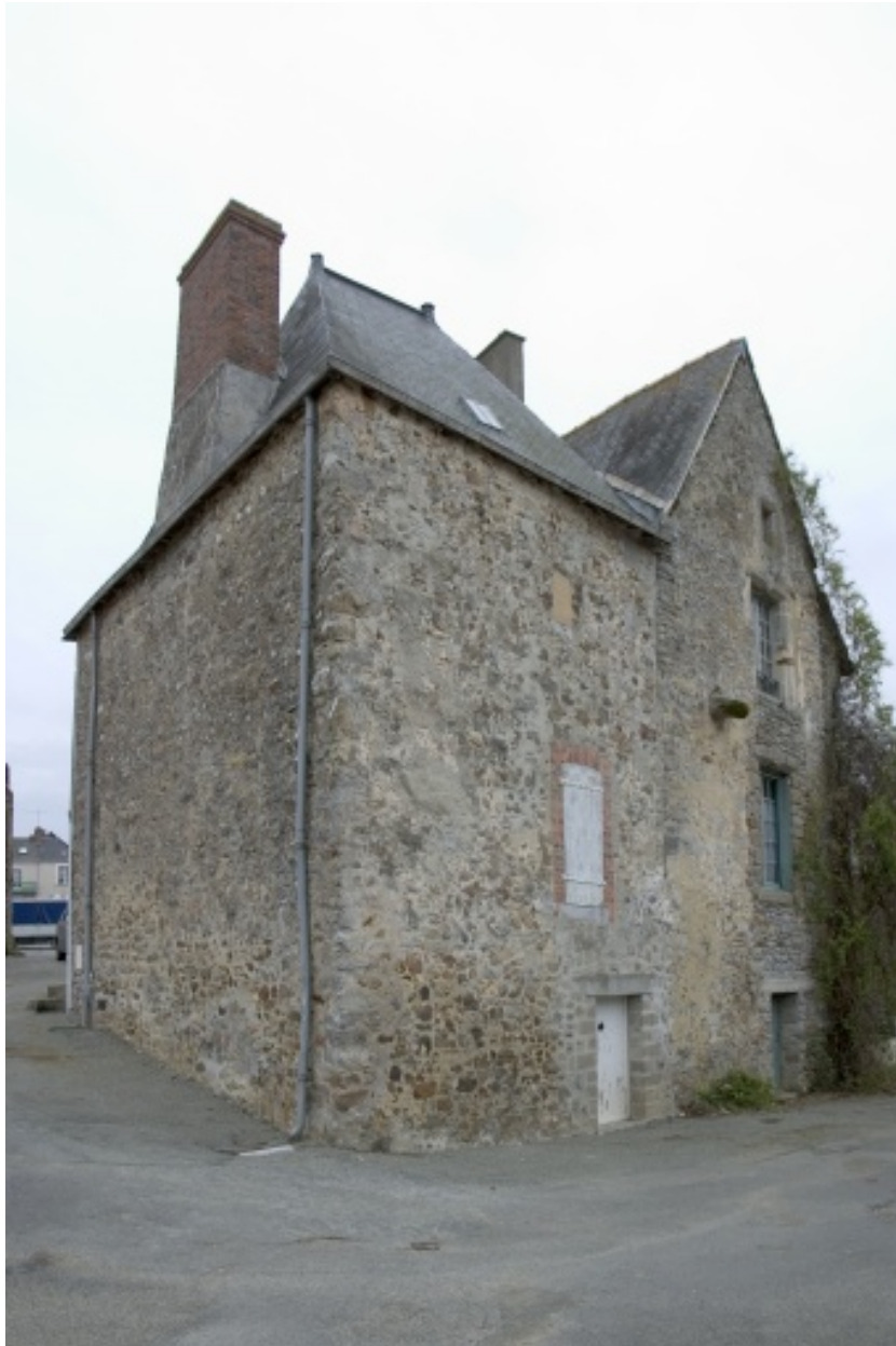
La maison vue depuis le nord-est.
