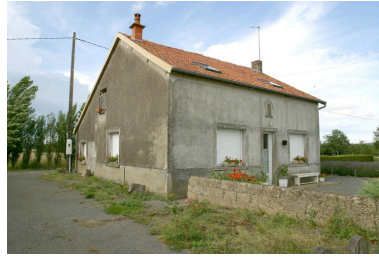
Vue d'ensemble depuis la route au sud-ouest. Phot. François Lasa IVR52_20035302244NUCA
