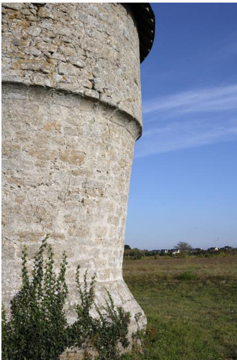
Profil de la tourelle et de l'encorbellement de la cage. Vue prise côté sud de la tourelle.
