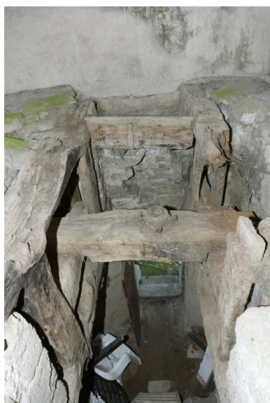
Intérieur de la cage. Vue de la partie supérieure de la trempure, d'ouest en est. À droite, cadre nord, à gauche, cadre sud. Au centre, le palier et sa crapaudine. Au fond, huche de réception de farine. Phot. Denis Pillet IVR52_20074401558NUCA
