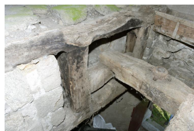
Intérieur de la cage. Charpente de la trempure, détail du cadre nord.
