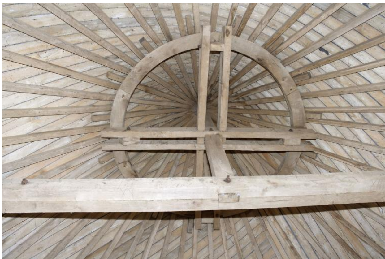
Intérieur de la coiffe restaurée. Détail de l'enrayure et du lattis. Vue de bas en haut.
