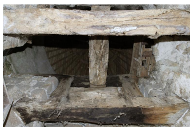
Intérieur de la cage. Vue de la partie supérieure de la trempure, d'ouest en est. À droite, cadre nord, à gauche, cadre sud. Au centre, le palier et sa crapaudine. Au fond, huche de réception de farine. Phot. Denis Pillet IVR52_20074401558NUCA
