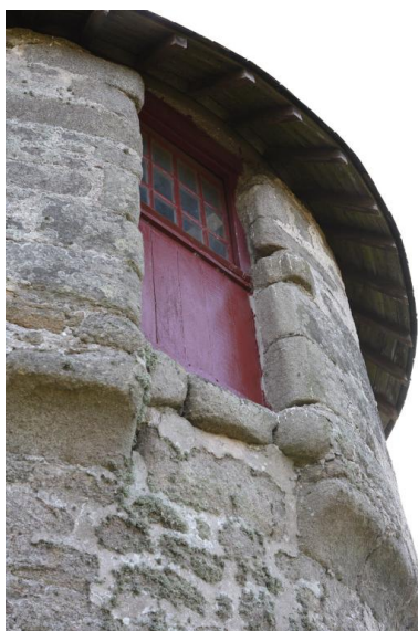
Porte haute nord. Phot. Denis Pillet IVR52_20074401546NUCA
