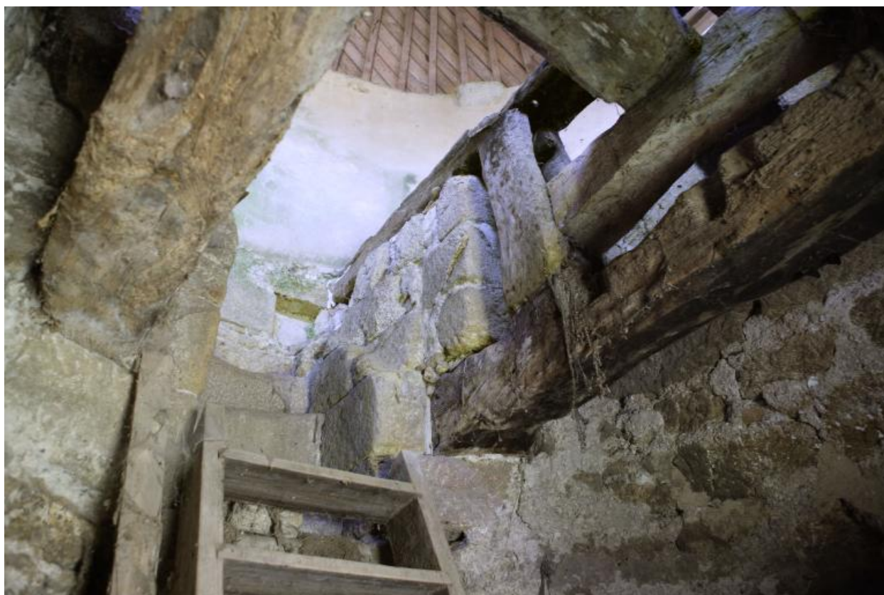
Intérieur. Échelle et escalier d'accès à la cage. À droite, cadre nord de la charpente de la trempure.
