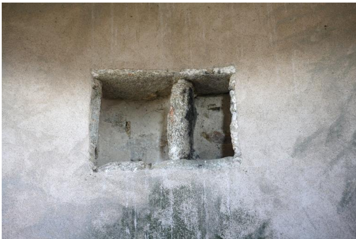
Cage, secteur est. Détail d'une niche.
