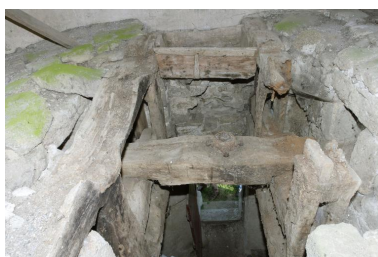
Intérieur de la cage. Vue de la partie supérieure de la trempure, d'ouest en est. À droite, cadre nord, à gauche, cadre sud. Au centre, le palier et sa crapaudine. Au fond, huche de réception de farine. Phot. Denis Pillet IVR52_20074401557NUCA
