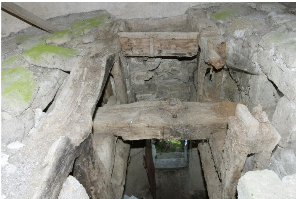
Intérieur de la cage. Vue de la partie supérieure de la trempure, d'ouest en est. À droite, cadre nord, à gauche, cadre sud. Au centre, le palier et sa crapaudine. Au fond, huche de réception de farine.
