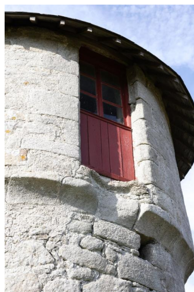
Porte haute sud et détail de l'encorbellement de la cage. Phot. Denis Pillet IVR52_20074401550NUCA
