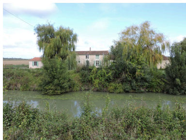
La cabane vue depuis le sud. Phot. Yannis Suire IVR52_20198503147NUCA
