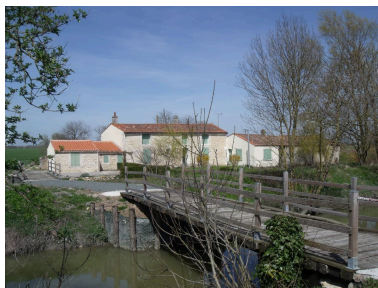
La Millenchère vue depuis le sud-ouest vers 2000. Phot. Yannis Suire IVR52_20198503762NUCA
