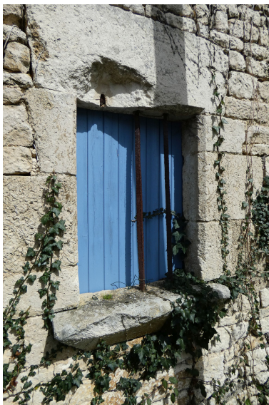
Baie à appui mouluré sur la façade sud de la dépendance ouest. Phot. Yannis Suire IVR52_20238501065NUCA
