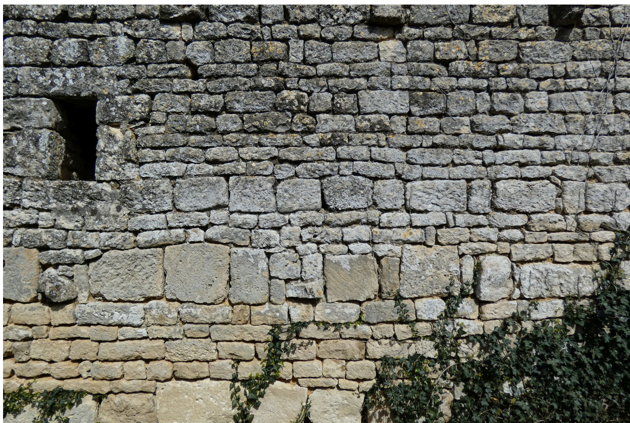
Détail de la maçonnerie de la dépendance ouest, à assises régulières de moellons équarris.
