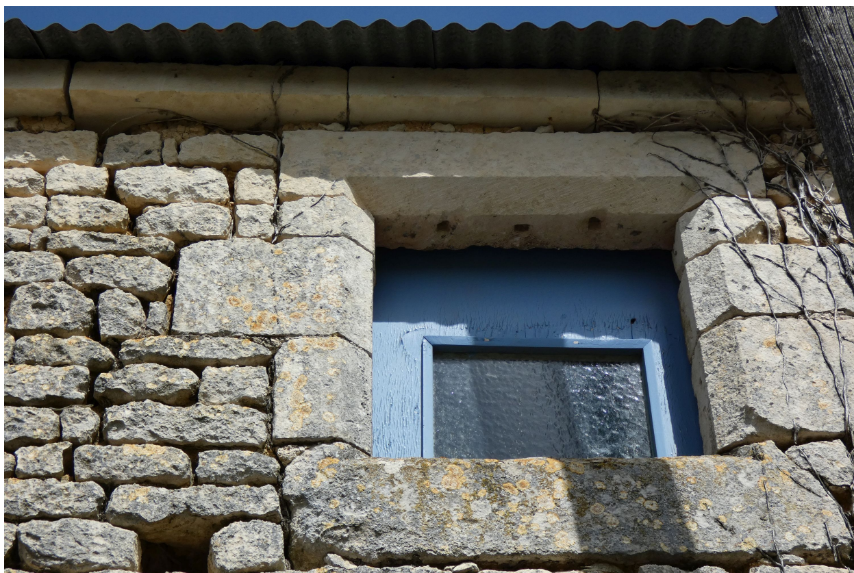
Baie à encadrement chanfreiné sur la façade sud de la dépendance ouest.
