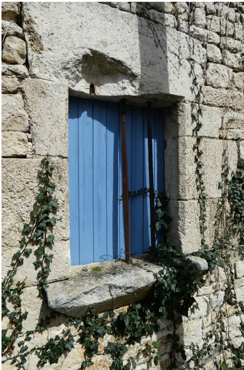
Baie à appui mouluré sur la façade sud de la dépendance ouest.
