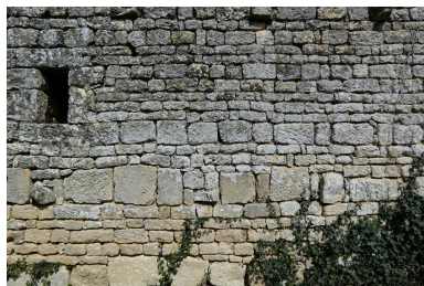
Détail de la maçonnerie de la dépendance ouest, à assises régulières de moellons équarris. Phot. Yannis Suire IVR52_20238501064NUCA
