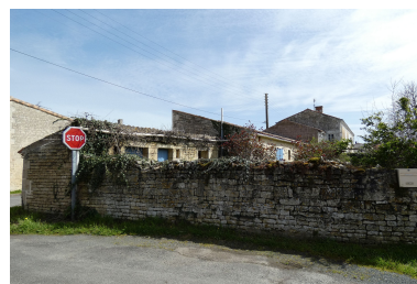
Le toit à porcs dans l'angle nord de la ferme, rue du Mouton. Phot. Yannis Suire IVR52_20238501069NUCA
