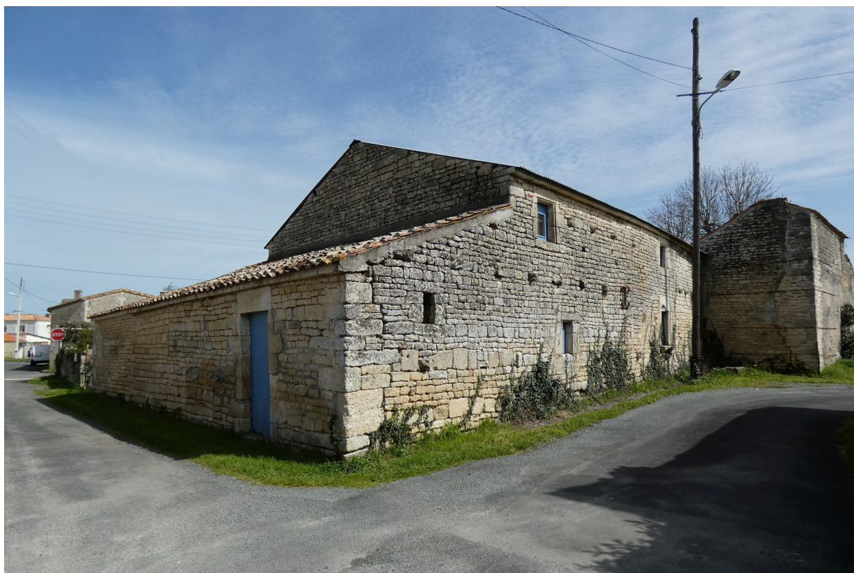
La dépendance du 17e ou 18e siècle dans l'angle ouest de la ferme, vue depuis l'ouest.
