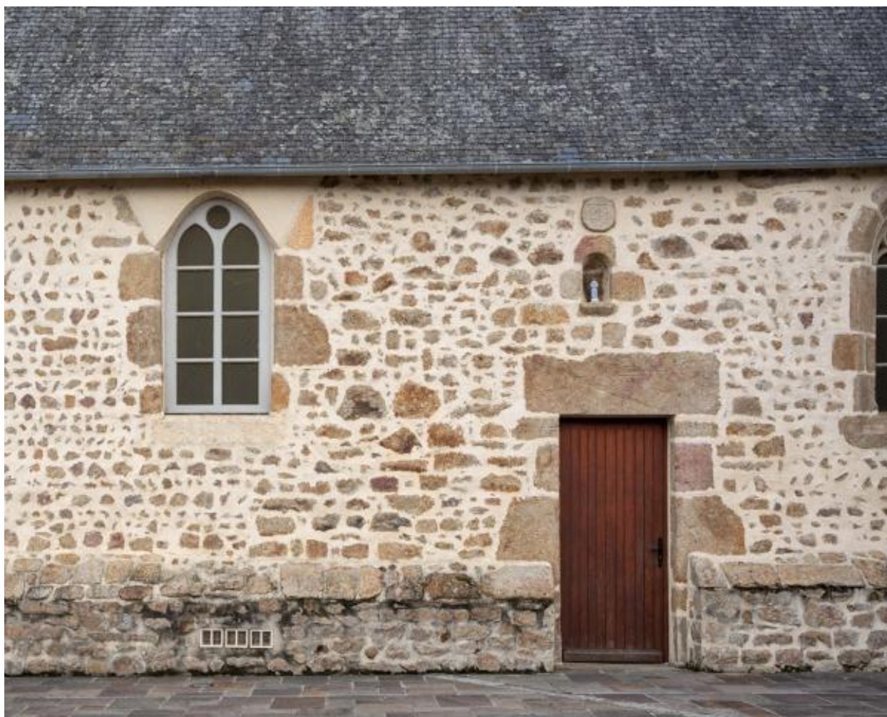
Le mur sud de la nef, détail.
