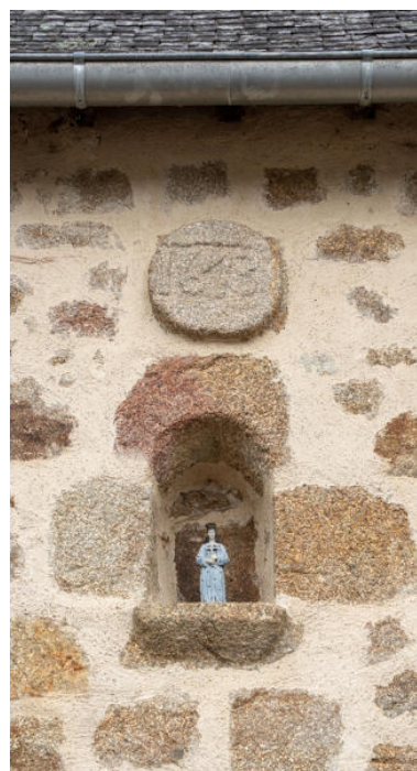
Une niche et une date portée sur le mur sud de la nef. Phot. Pierre-Bernard Fourny IVR52_20215300401NUCA
