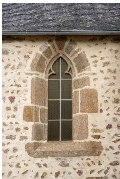
Une baie gothique du mur sud de la nef. Phot. Pierre-Bernard Fourny IVR52_20215300399NUCA
