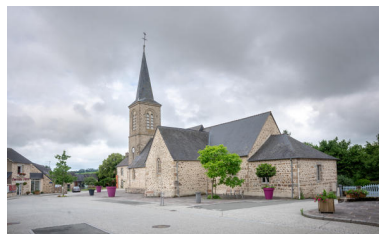
L'église depuis le sud-est. Phot. Pierre-Bernard Fourny IVR52_20215300398NUCA
