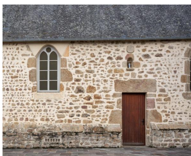
Le mur sud de la nef, détail. Phot. Pierre-Bernard Fourny IVR52_20215300402NUCA
