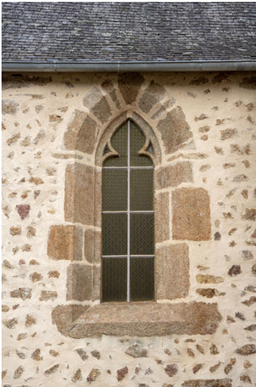
Une baie gothique du mur sud de la nef.
