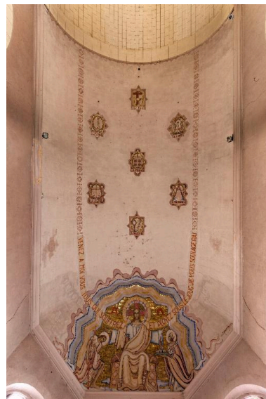
Le décor peint de 1921 sur la fausse-voûte couvrant le chœur. Phot. Yves Guillotin IVR52_20147202086NUCA
