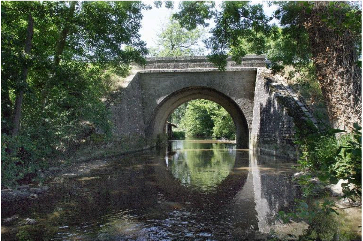
Vue depuis l'aval.
