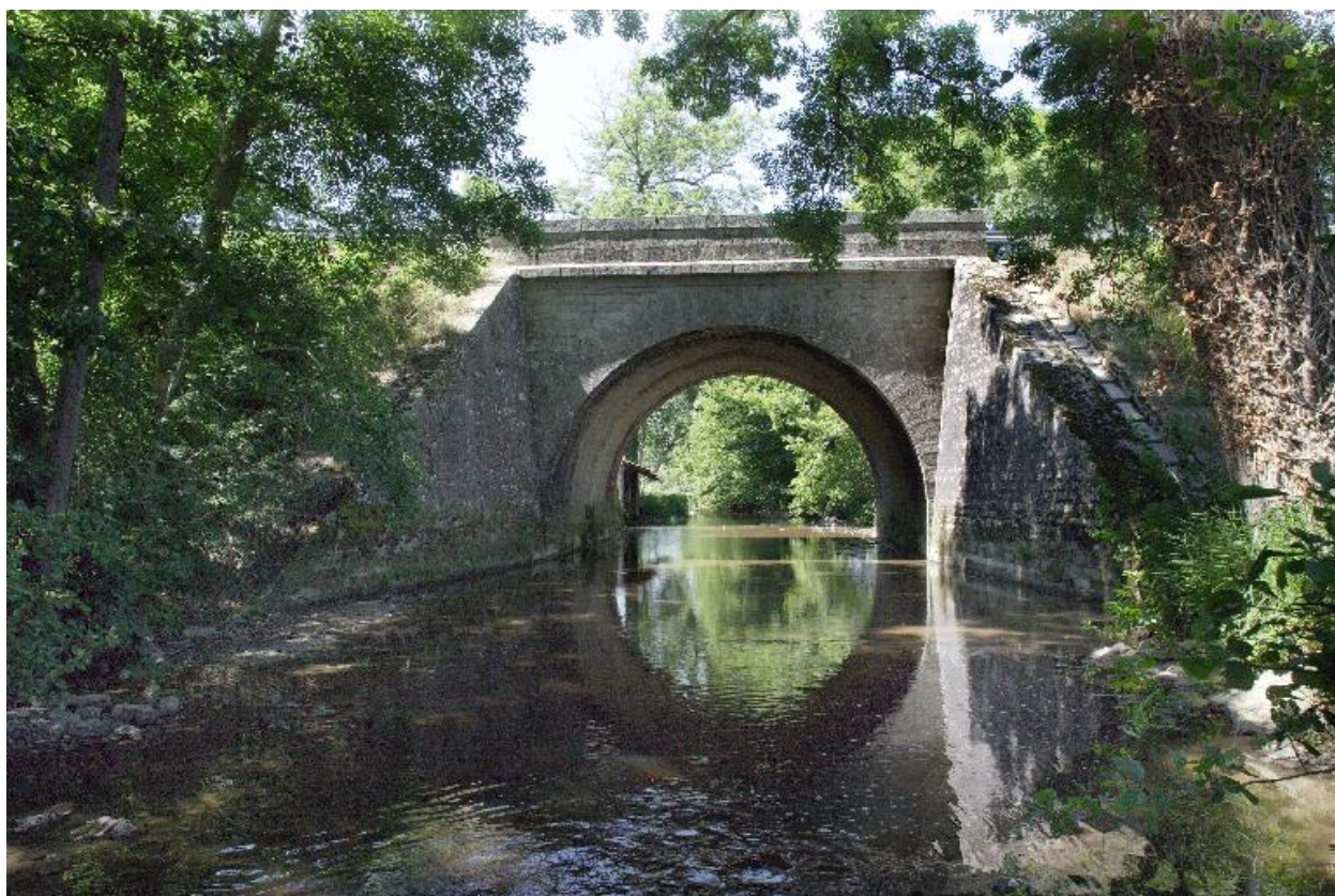
Vue depuis l'aval.
