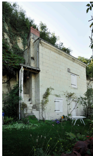
Maison en appentis, accollée au coteau. Phot. Bruno Rousseau, Phot. Youenn Communeau IVR52_20114902683NUCA
