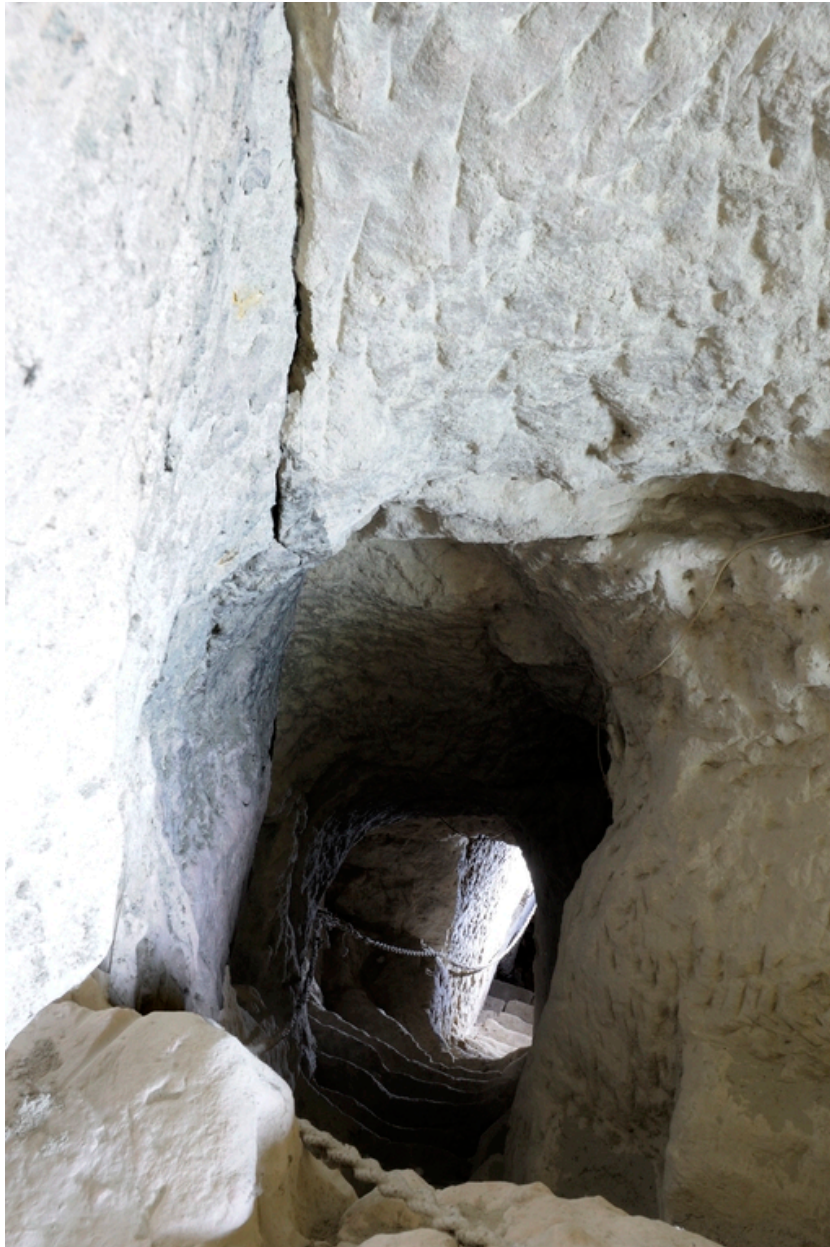
Débouché des escaliers, dans la salle haute.
