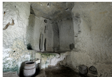
Vestiges de pressoir casse-col, avec écoulement de la maie vers une petite fosse à vaisselle vinaire. Phot. Bruno Rousseau IVR52_20134900802NUCA
