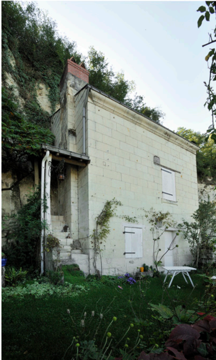
Maison en appentis, accolée au coteau.
