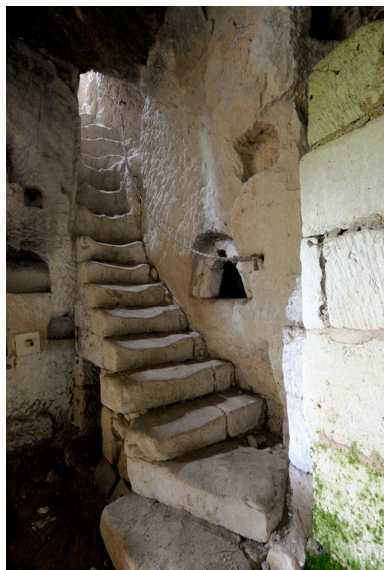
Escaliers intérieurs d'accès à la salle haute, taillés dans la roche. Phot. Bruno Rousseau IVR52_20134900792NUCA
