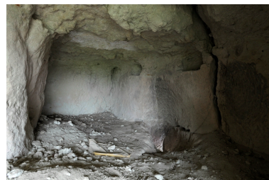
Salle haute. Phot. Bruno Rousseau IVR52_20134900795NUCA
