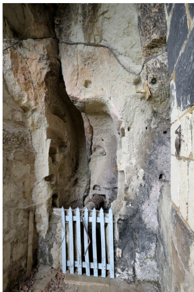
Puits à l'entrée de l'abri troglodytique, avec dans la roche les traces de l'ancienne roue. Phot. Bruno Rousseau IVR52_20134900800NUCA
