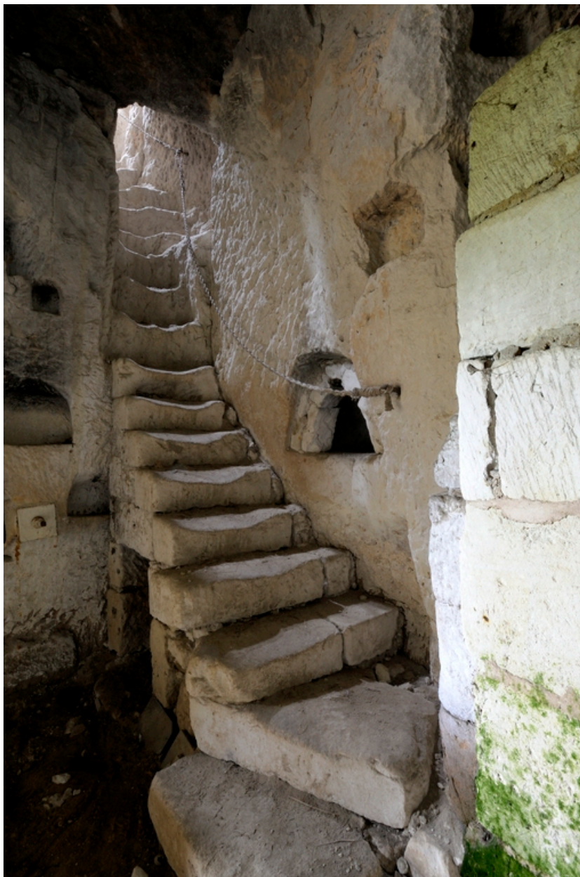
Escaliers intérieurs d'accès à la salle haute, taillés dans la roche.
