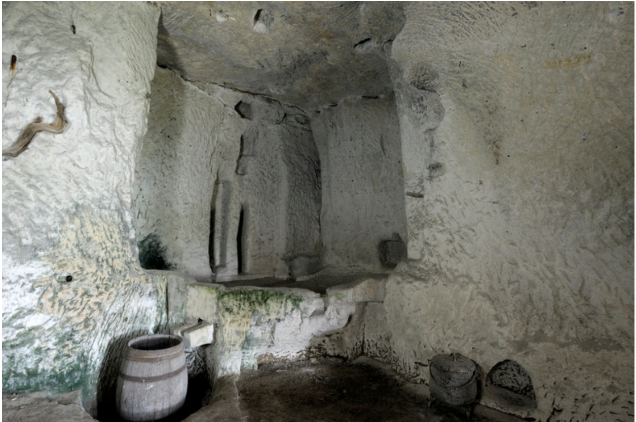
Vestiges de pressoir casse-col, avec écoulement de la maie vers une petite fosse à vaisselle vinaire.
