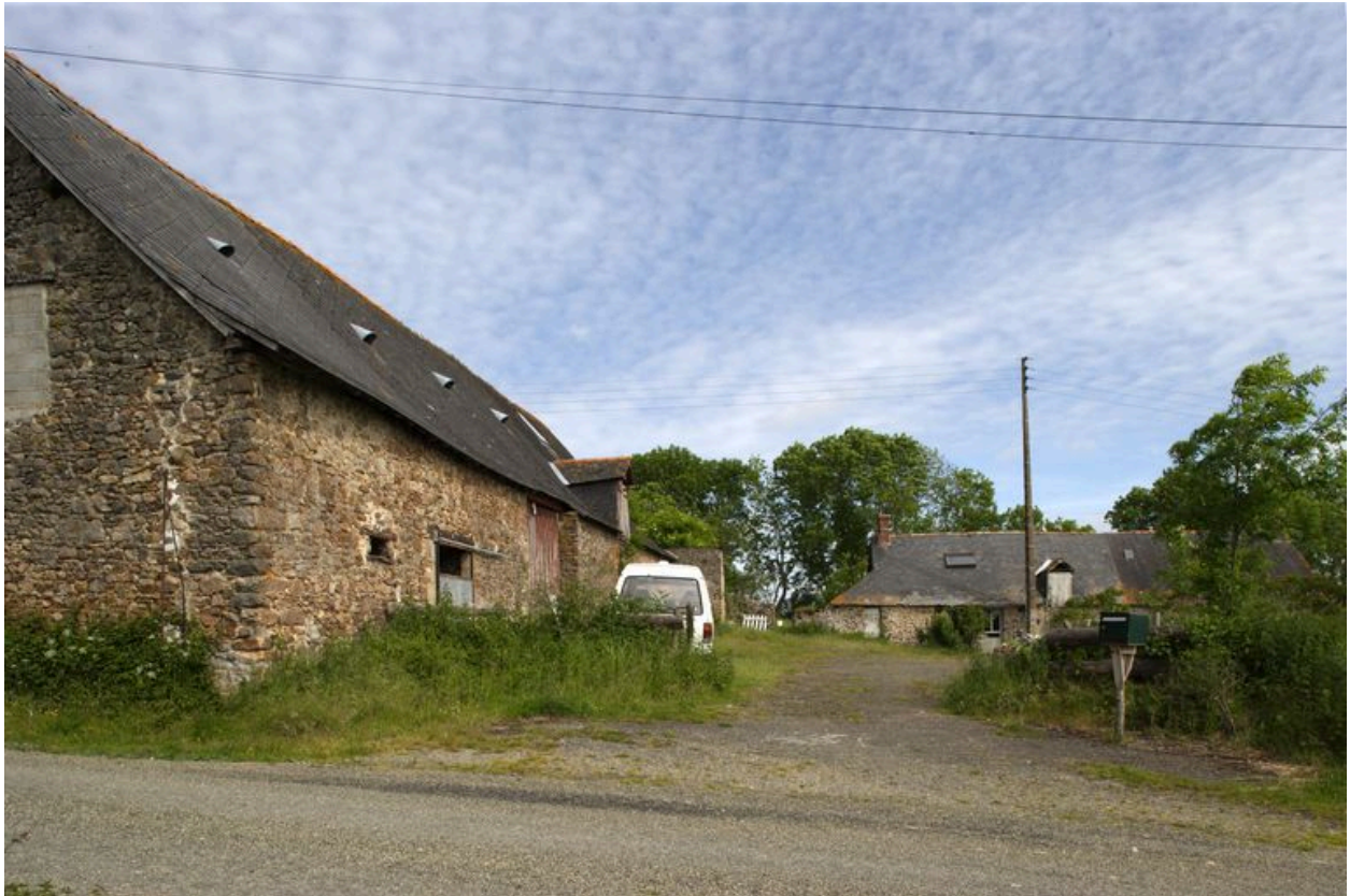
L'étable-grange et le logis vus depuis le chemin au sud.
