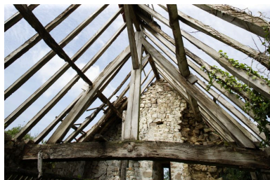
La charpente de la seconde étable.
