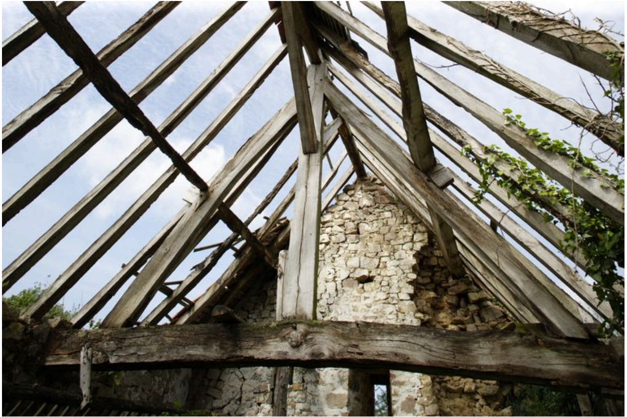
La charpente de la seconde étable.
