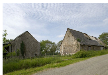
La remise et la seconde étable vues depuis le chemin au nord-est.
