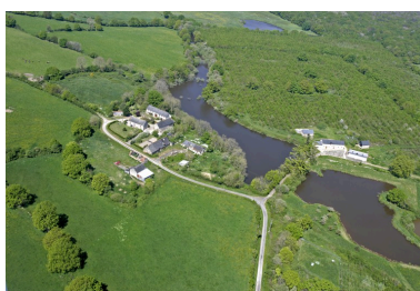
Vue aérienne d'ensemble depuis le sud-est. À gauche, les Hauts-Pins, à droite les Bas-Pins. Phot. François Lasa IVR52_20075301865NUCA
