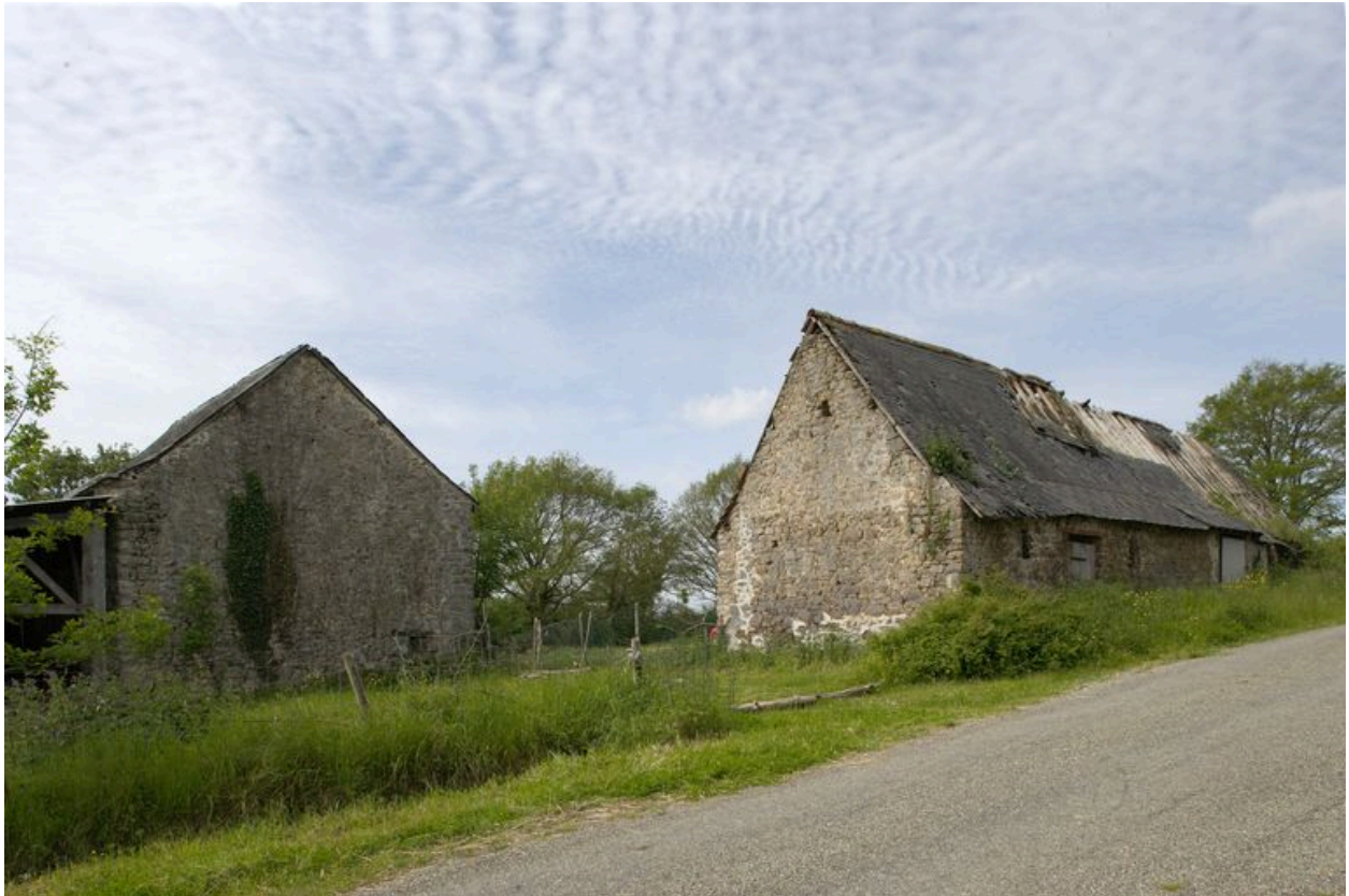
La remise et la seconde étable vues depuis le chemin au nord-est.
