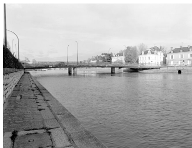
Vue d'ensemble du pont, depuis la rive droite en aval.
