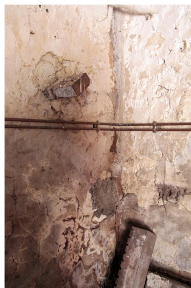
L'étable à vaches (D, E) trace d'un poteau de bois sur le mur pignon. Phot. Jean-Baptiste Darrasse IVR52_20097200478NUCA
