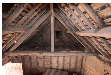
Ancienne maison (F), la charpente de l'ensemble et la cloison de pans de bois entre la dépendance et la remise. Phot. Jean-Baptiste Darrasse IVR52_20097200476NUCA
