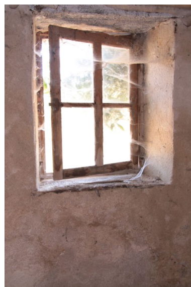
Ancienne maison (F), la chambre à feu : fenêtre carrée. Phot. Jean-Baptiste Darrasse IVR52_20097200473NUCA
