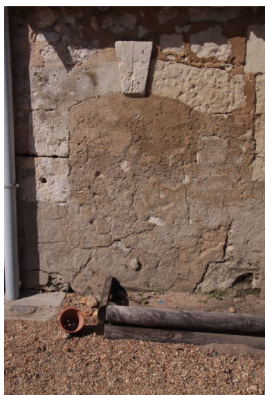
L'étable à vaches (D, E) : porte murée, couverte en anse-de-panier. Phot. Jean-Baptiste Darrasse IVR52_20097200479NUCA
