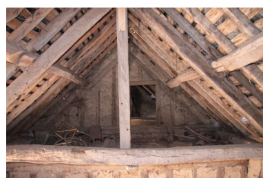
Ancienne maison (F) : la charpente au-dessus de la dépendance et le pignon en pans de bois qui sépare l'étable et la chambre manable. Phot. Jean-Baptiste Darrasse IVR52_20097200475NUCA
