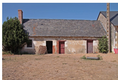
Ancienne maison (F), façade antérieure sur cour avec trois portes : la chambre à feu, petite dépendance puis remise ou grange. Phot. Jean-Baptiste Darrasse IVR52_20097200470NUCA
